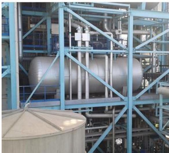
Figura 5.23 - Tanque de condensados da CTB [73].
