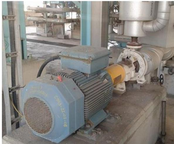
**Figura 5.24** - Bomba nº1 de Condensados [73].
