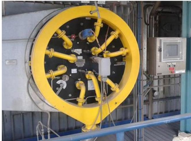
**Figura 5.11** - Queimador de carga de GN da caldeira LFB da CTB [73].
