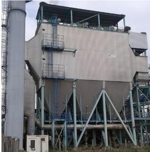
**Figura 5.13** - Precipitador eletrostático da CTB [73].
