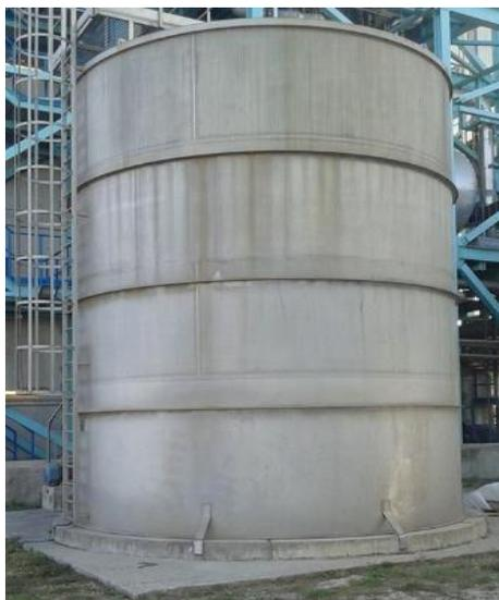
Figura 5.25 - Tanque de Desmineralização [73].
