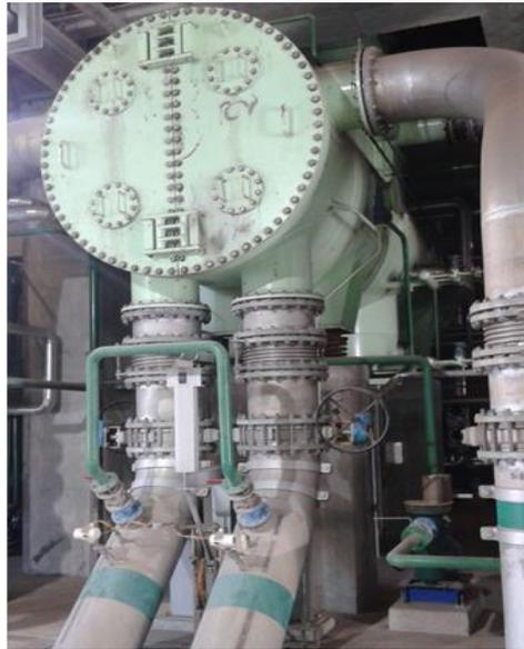
**Figura 5.21** - Condensador da CTB [73].
