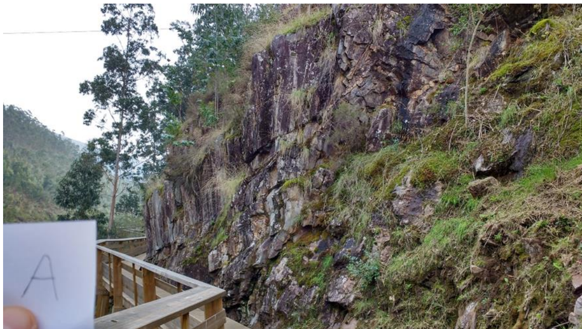
Figura IV-7 Aspeto geral do talude referido como secção A
