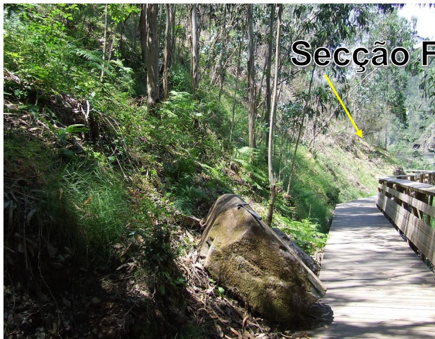
Figura IV-28 Bloco solto junto aos passadiços depois da secção F
