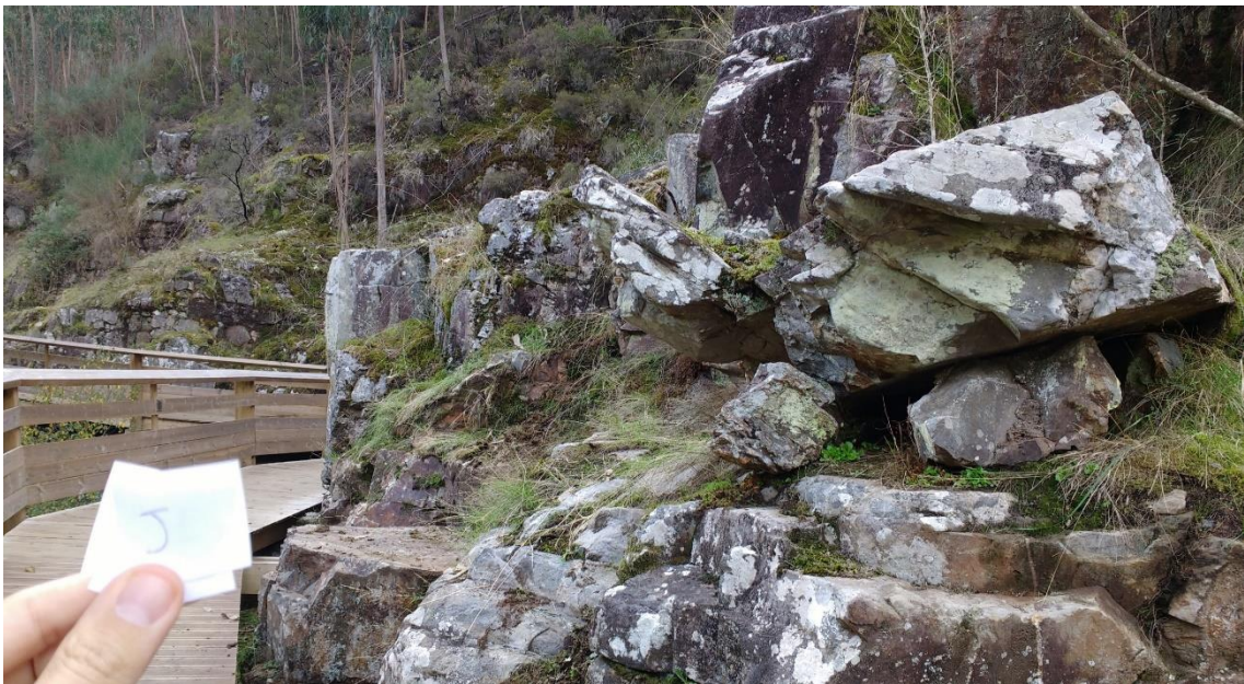
Figura IV-40 Aspeto geral do talude referido como secção J
