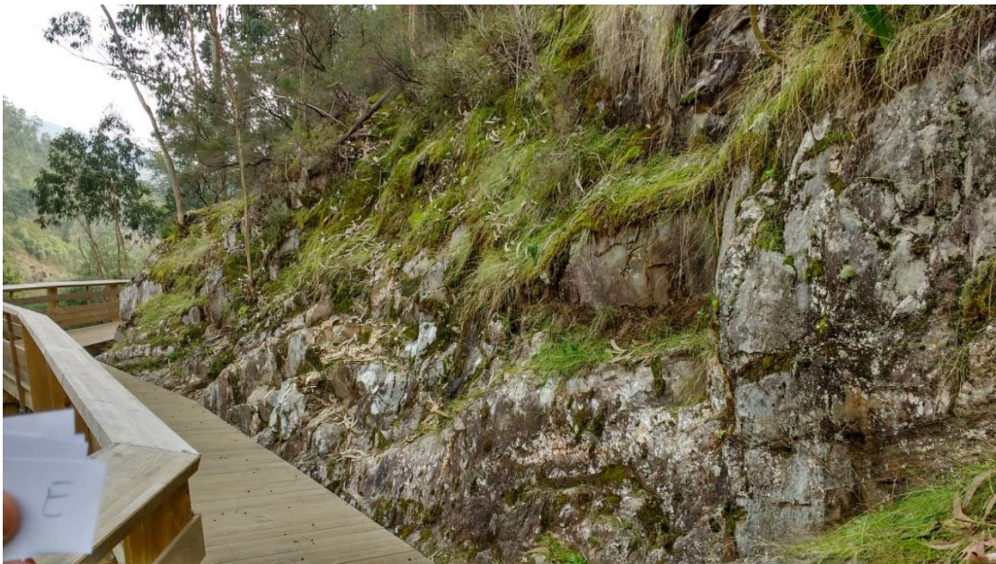
Figura IV-21 Aspeto geral do talude referido como secção E
