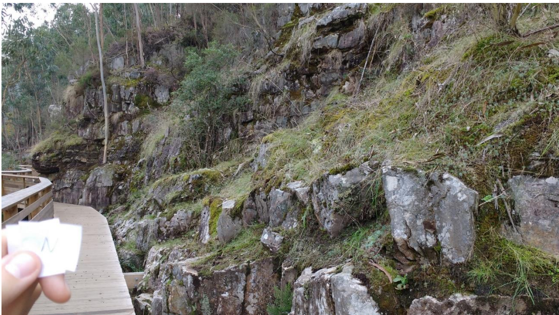
Figura IV-49 Aspeto geral do talude referido como secção N
