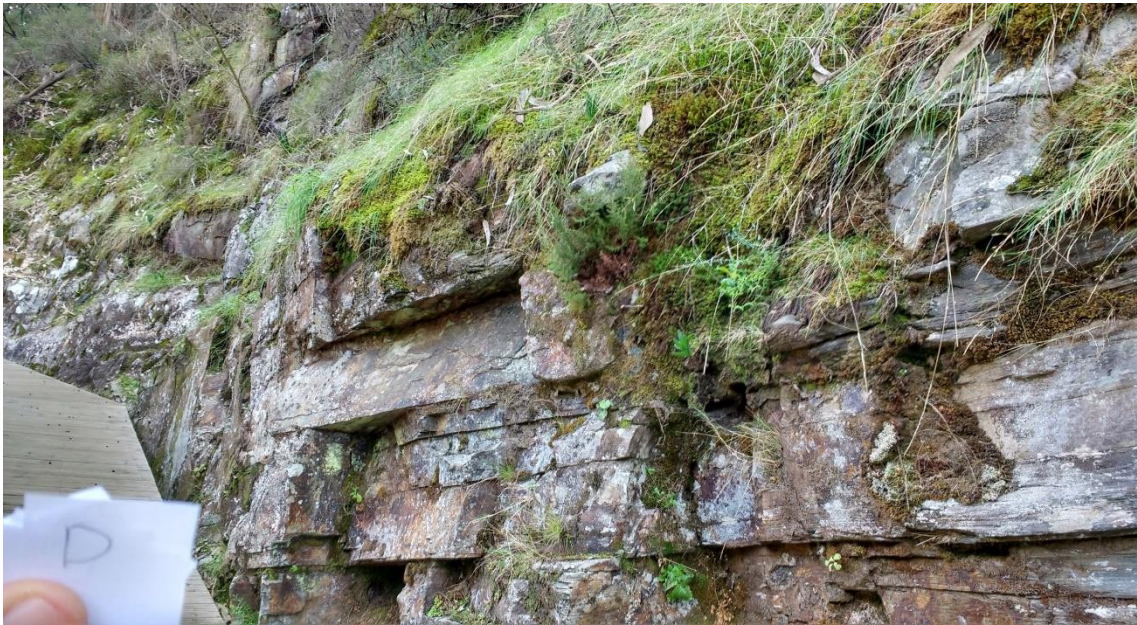
Figura IV-18 Aspeto geral do talude referido como secção D
