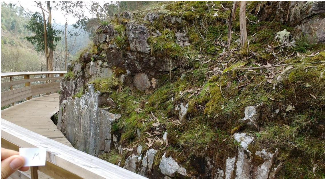
Figura IV-46 Aspeto geral do talude referido como secção M
