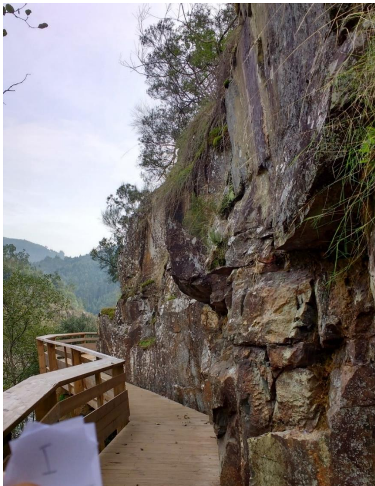
Figura IV-37 Aspeto geral do talude referido como secção I
