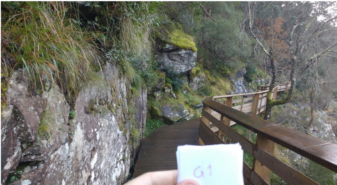
Figura IV-102 Aspeto geral dos taludes referidos como secção G1
