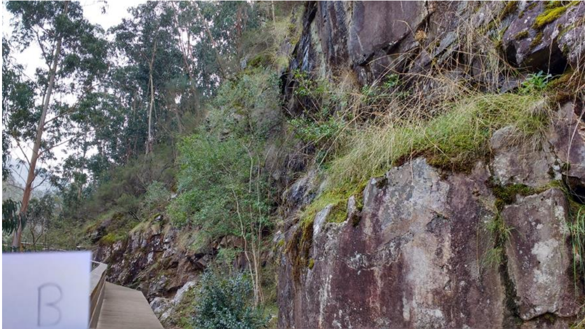
Figura IV-11 Aspeto geral do talude referido como secção B
