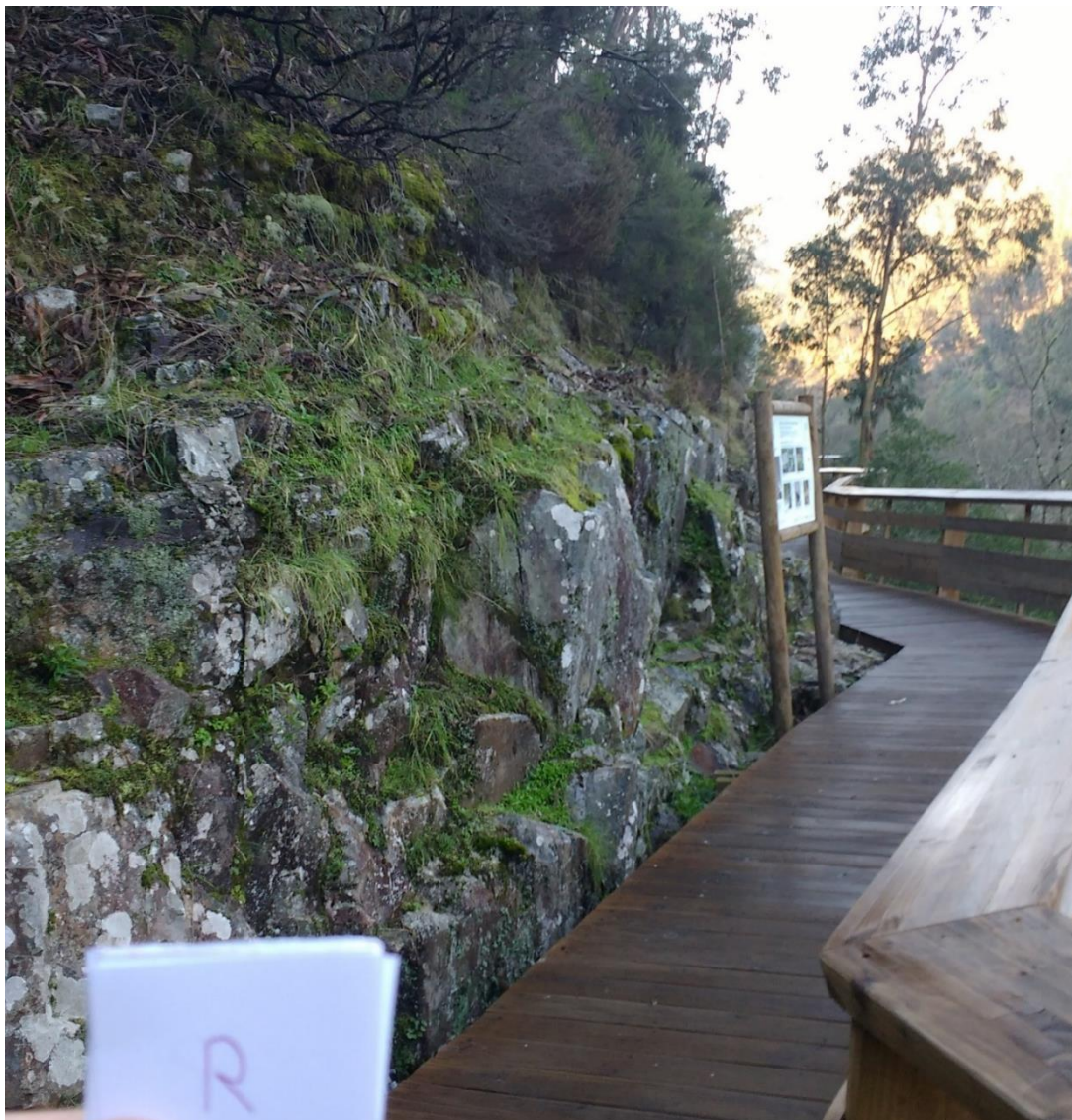
Figura IV-61 Aspeto geral do talude referido como secção R
