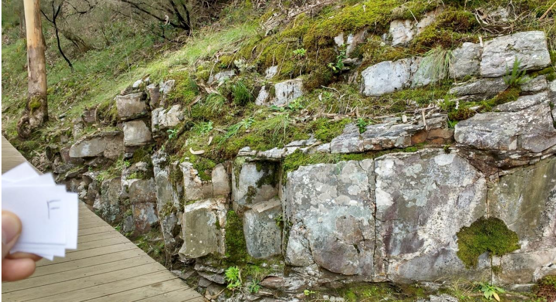
Figura IV-25 Aspeto geral do talude referido como secção F
