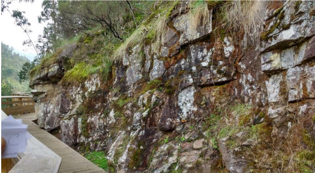
Figura IV-15 Aspeto geral do talude referido como secção C
