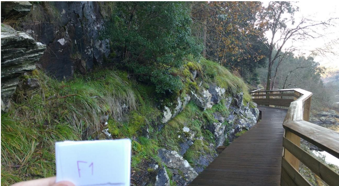
Figura IV-99 Aspeto geral dos taludes referidos como secção F1
