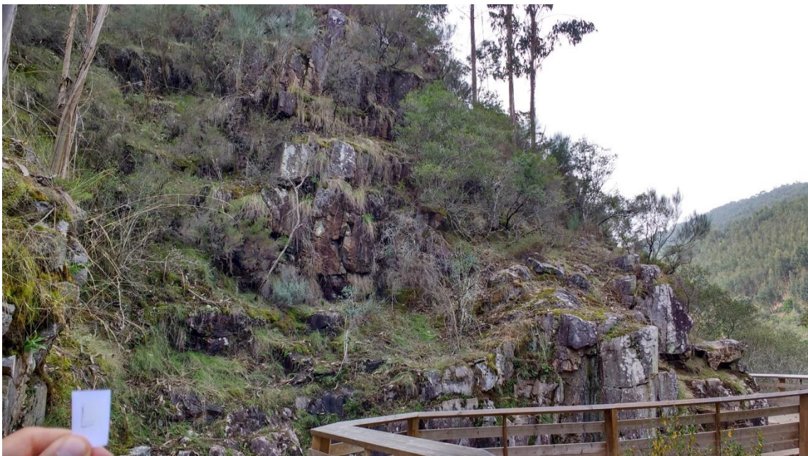
Figura IV-43 Aspeto geral do talude referido como secção L
