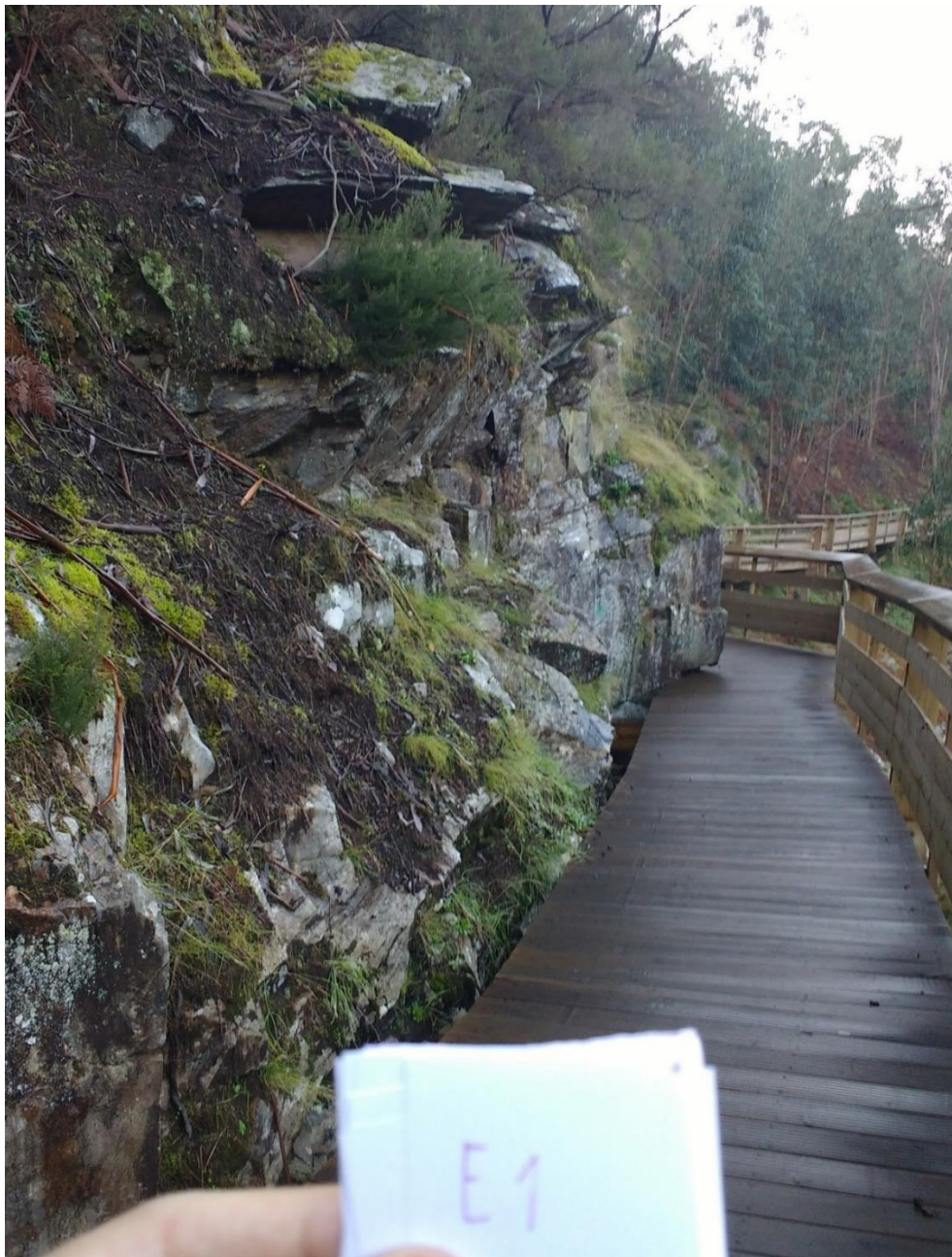
Figura IV-96 Aspeto geral dos taludes referidos como secção E1
