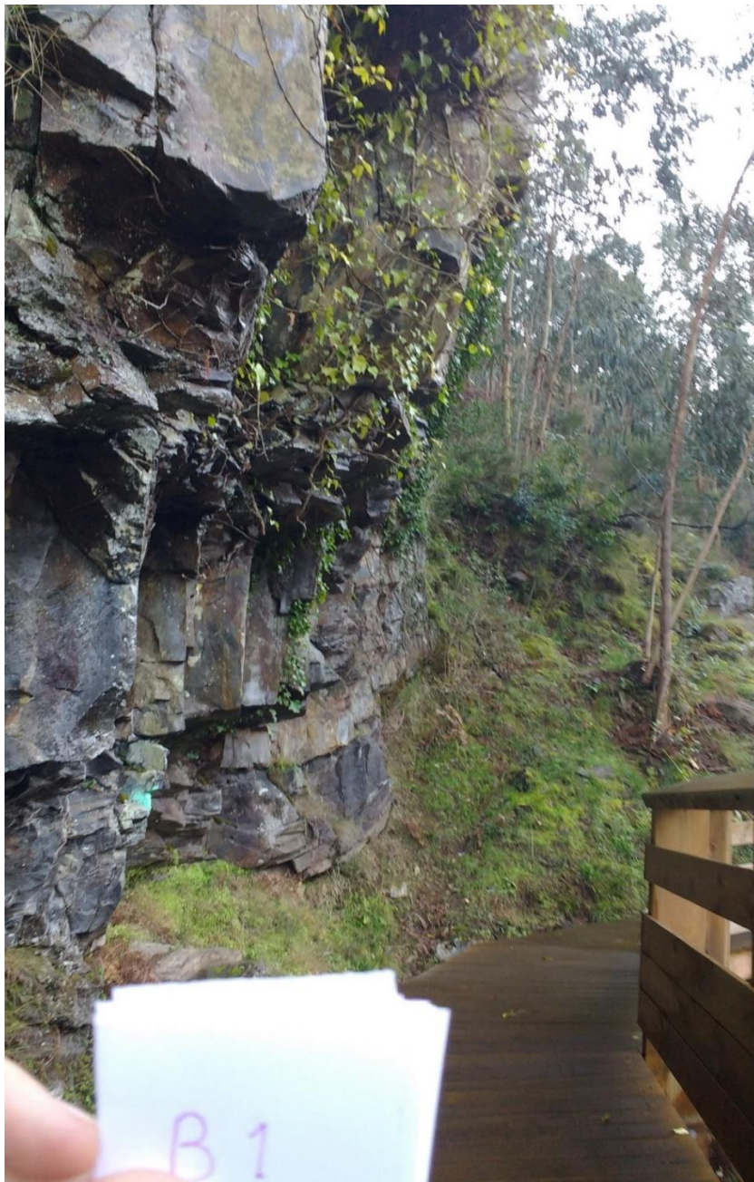
Figura IV-85 Aspeto geral do talude referido como secção B1
