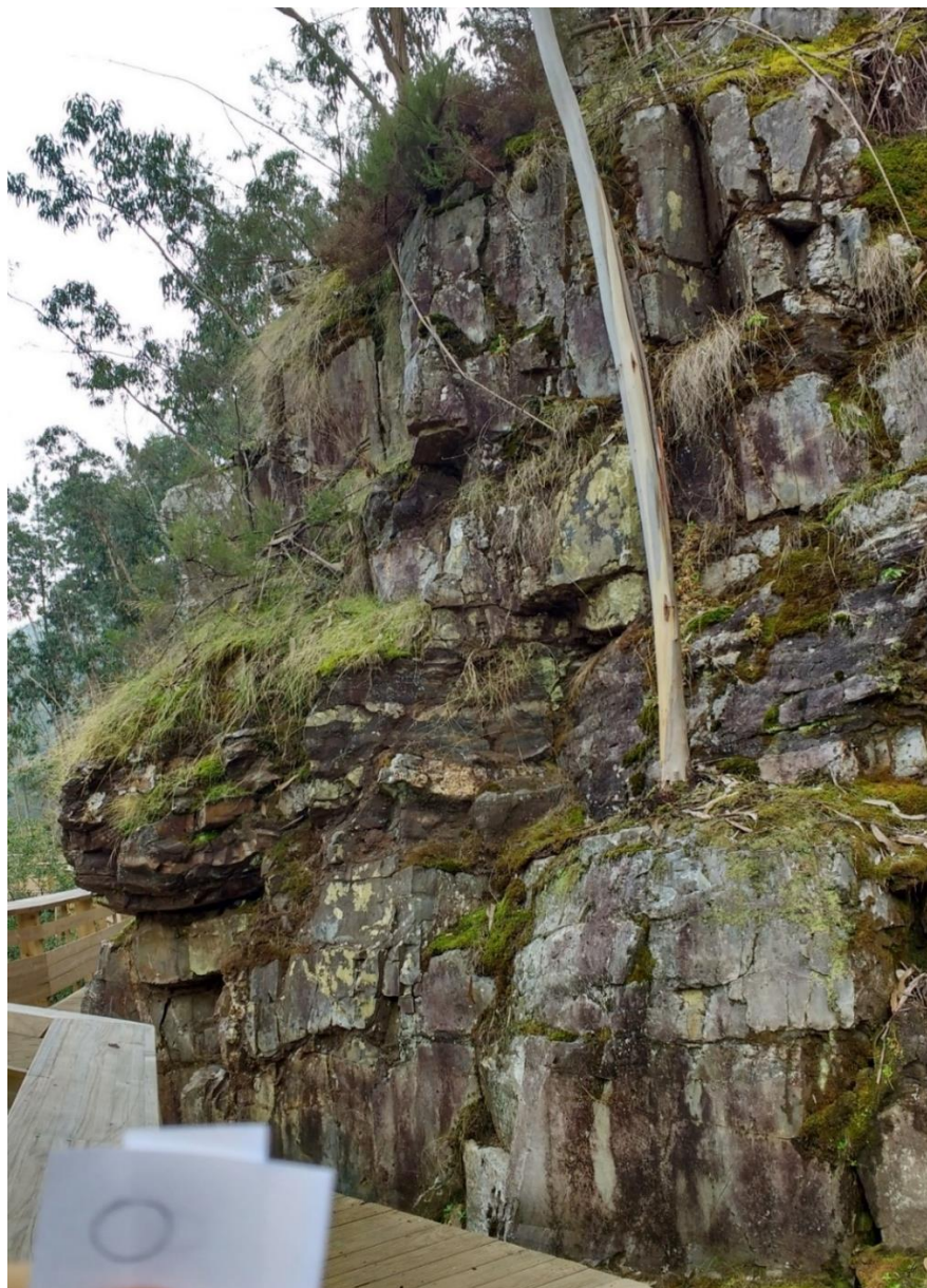
Figura IV-52 Aspeto geral do talude referido como secção O
