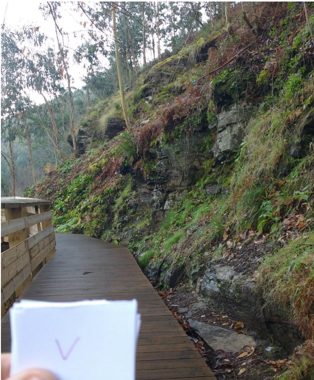
Figura IV-73 Aspeto geral do talude referido como secção V
