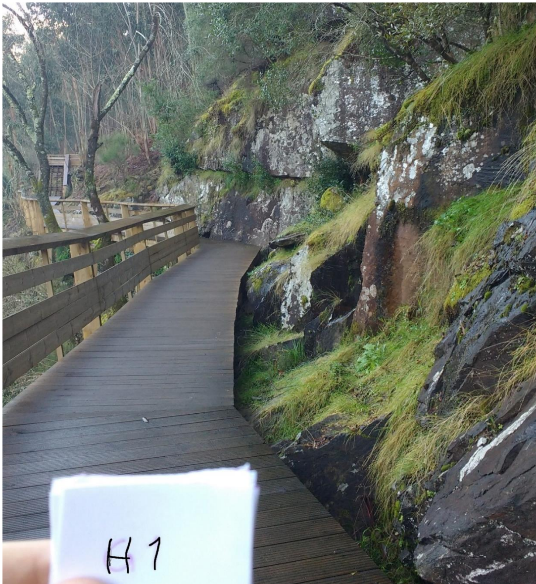
Figura IV-105 Aspeto geral dos taludes referidos como secção H1
