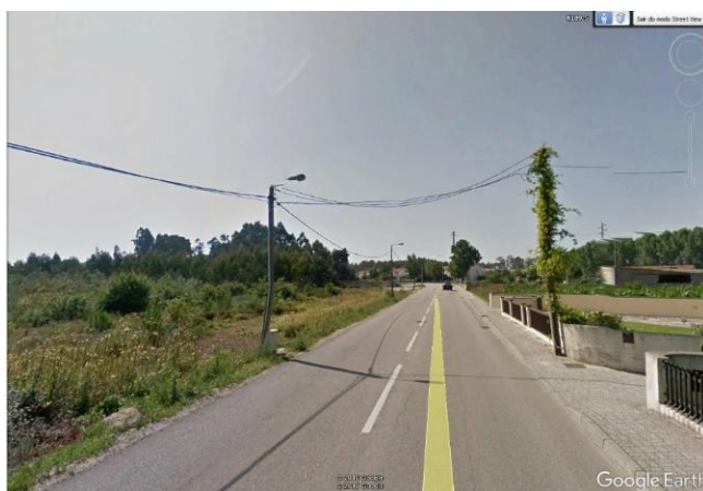
Figura 6.74 - Troço da Estrada N109-5 (imagem retirada do Google Earth)
