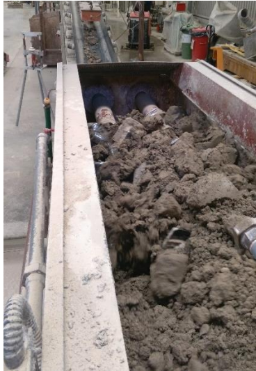
Figura 3 – Misturador de duplo eixo (M6) onde ocorre a humedificação e coloração da pasta a extrudir.
