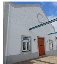
Figura 4.4 – Edifício após reabilitação
