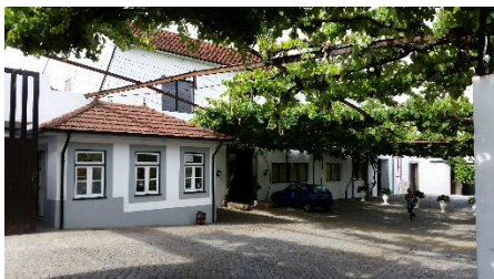
Figura 4.2 – Edifício antes da reabilitação
