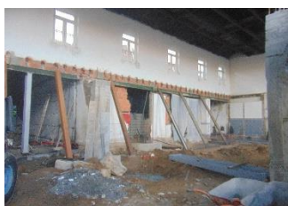
Figura 4.5 – Edifício durante reabilitação
