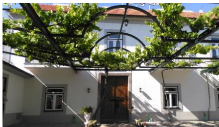
Figura 4.3 – Edifício após reabilitação
