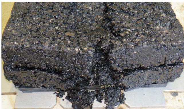
Figura 4.42 – Deformação excessiva nas lajes a 60°C
