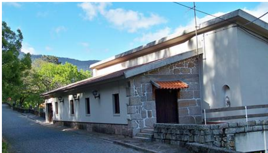
Figura 1.9 - Unidade Hoteleira de Manteigas (INATEL, [W 4 ])
