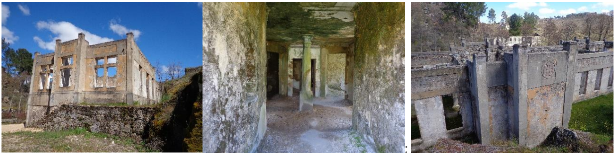
Figura 4.5 - Ruínas do antigo balneário termal do Cró (foto do autor, 2016)
