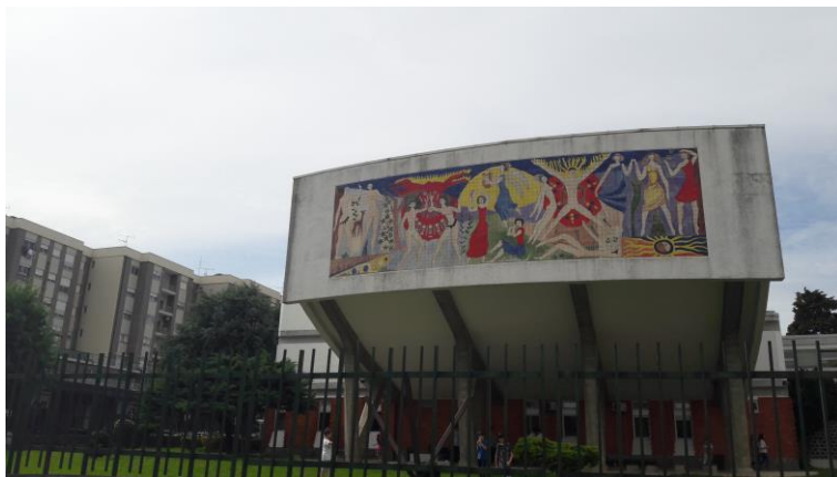
Figura 2. Vista exterior do CMCGB.
