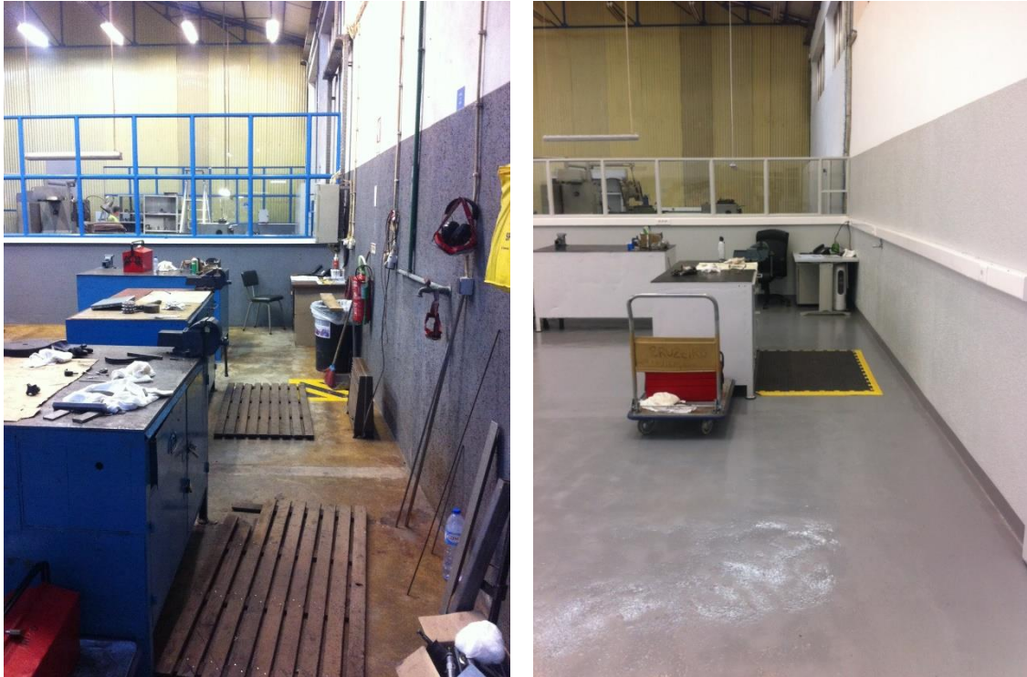
Figura 42 - Área das bancadas da oficina mecânica (Antes: imagem esquerda; Depois: imagem direita).
