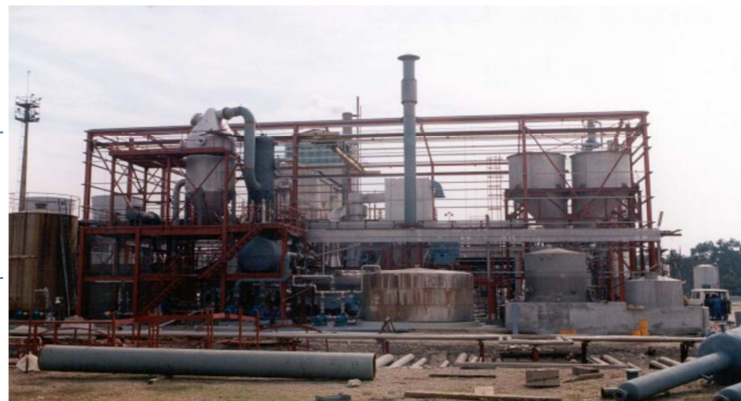
Montagem do equipamento
