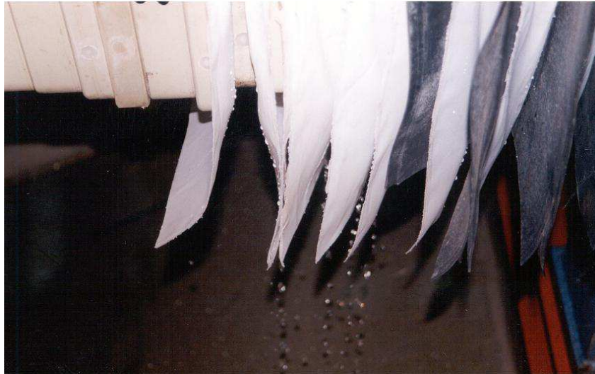
Figura 3.2. Pormenor da deficiente vedação entre placas filtro prensa adquirido em 2ª mão [8]
