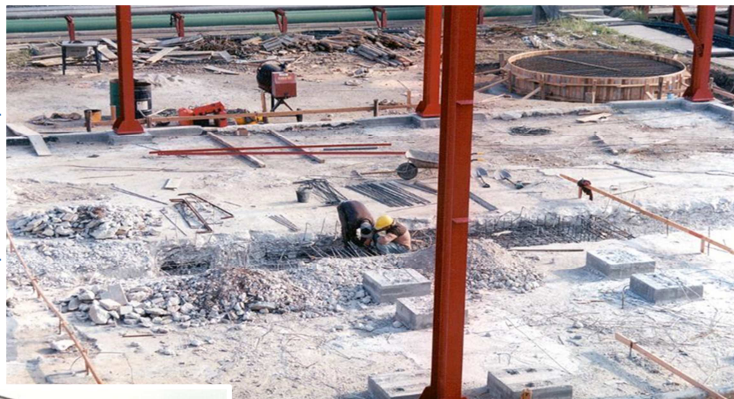
Fundações e muros
