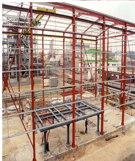
Conclusão da estrutura metálica do edifício
