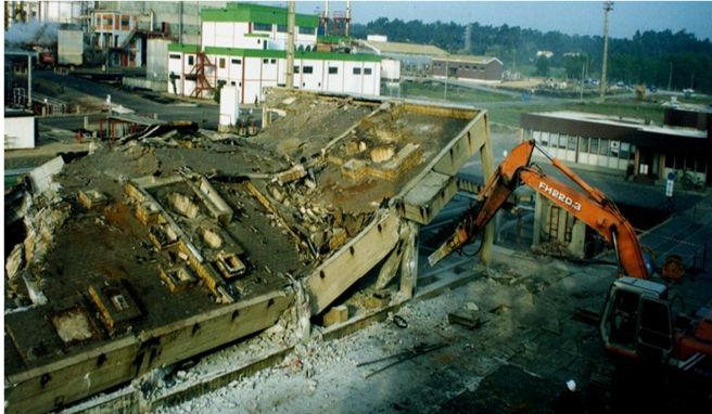
Demolição do edifício fabril existente
