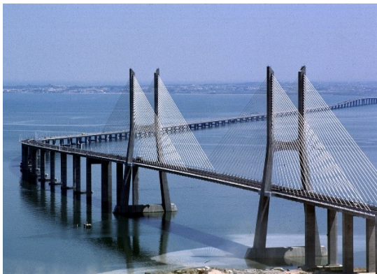
a) Vão central da ponte Vasco da Gama, onde o tabuleiro é atirantado.
