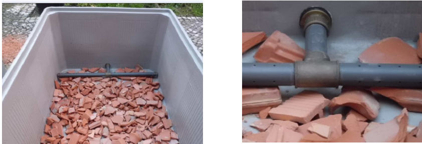
Figura 3.4 – Pormenor do enchimento de tijolo na base dos tanques - ZHC piloto.
