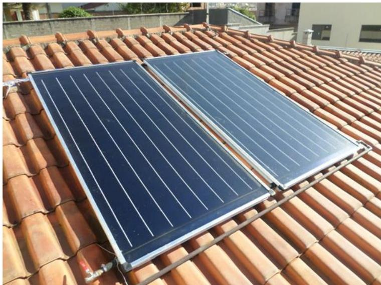
Figura 2.2 – Coletor solar plano com cobertura (ver URL6).
