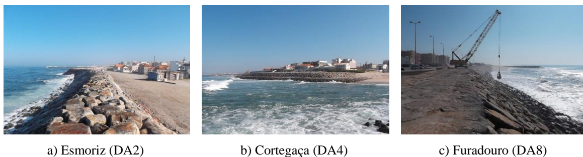
Figura 4.2: Vista das obras longitudinais aderentes em estudo (fonte: CMO, 2014).
