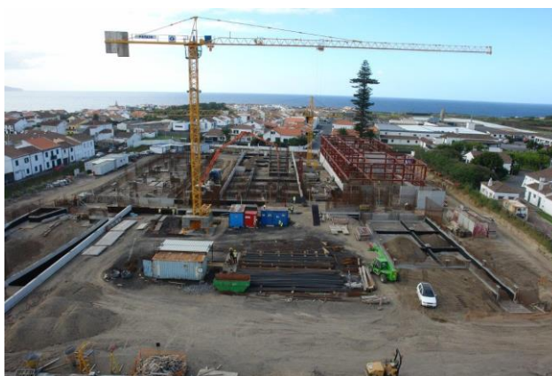
Figura 66 - Local da obra em estudo.
