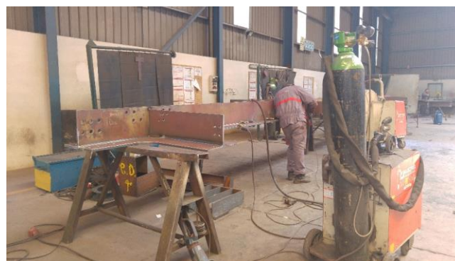
Figura 61 - Realização da armação em fábrica.
