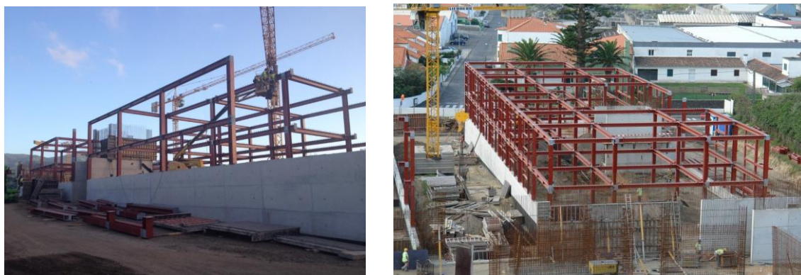
Figura 67 - Montagem da obra da Escola Gaspar Frutuoso.
