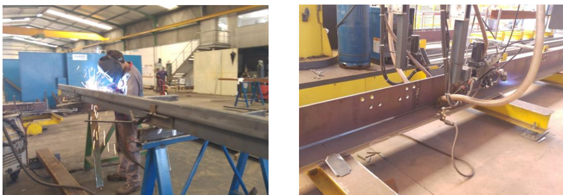
Figura 62 - Realização de soldaduras em fábrica.
