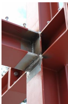
Figura 63 -Soldadura em obra de uma viga a um pilar.
