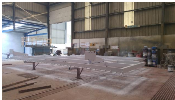
Figura 65 - Aplicação do tratamento superficial.
