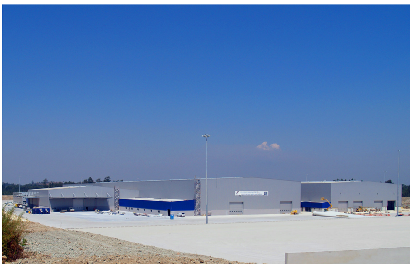
Figura 2.1: Instalações da RiaBlades (IPC Instalações Técnicas S.A, 2010).
