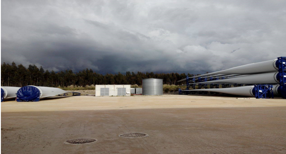
Figura 4.41: Estação de bombagem de água da RiaBlades.
