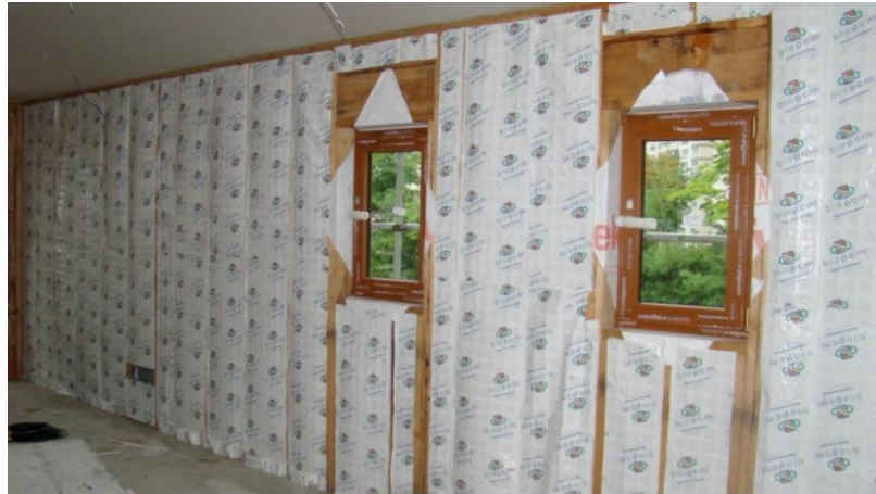
Figura 2.9 - Aplicação de PCMs numa parede pelo interior [15]
