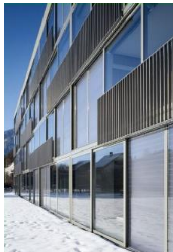
Figura 2.13 - Aplicação de PCMs nos envidraçados de um edifício [18]
