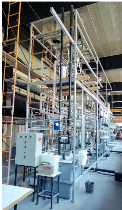
Figura 3.1: Torre Hidráulica da Universidade de Aveiro.
