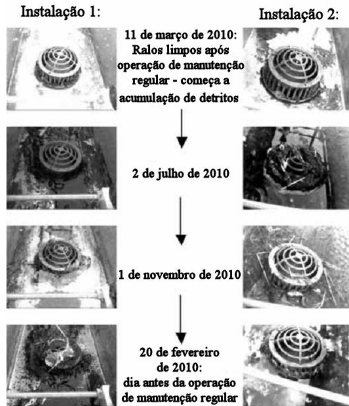
Figura 2.15: Imagens das caleiras, recolhidas entre operações de manutenção (adaptado de Beattie et al. (2011)).
