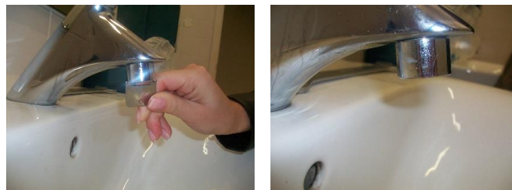
Figura 4.7 – a) Aplicação de um economizador com chave anti-roubo; b) Exemplo de um economizador aplicado numa torneira.
