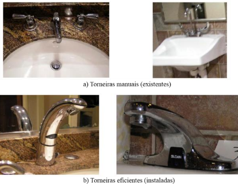
Figura 2.18 – Torneiras existentes no edifício em estudo a) Torneiras manuais; b) Torneiras eficientes (adaptado de Gauley e Koeller, 2010).
