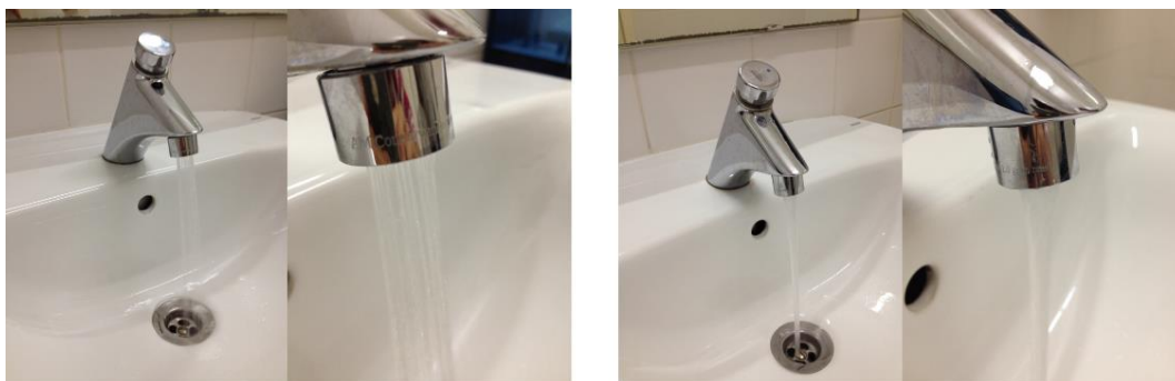
Figura 5.21 – Tipos de fluxo existentes a) fluxo laminado (economizador D); b) fluxo normal (economizador C).
