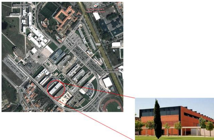
Figura 3.1 - Localização do edifício em estudo - DECivil (DigitalGlobe, 2015).
