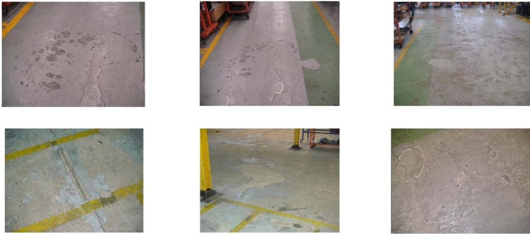
Fig. 39 - Imagens exemplificativas da degradação do piso da Fáb.1 da DFO
