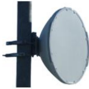
Figura 2-9 - Antena de Recepção do Sinal
