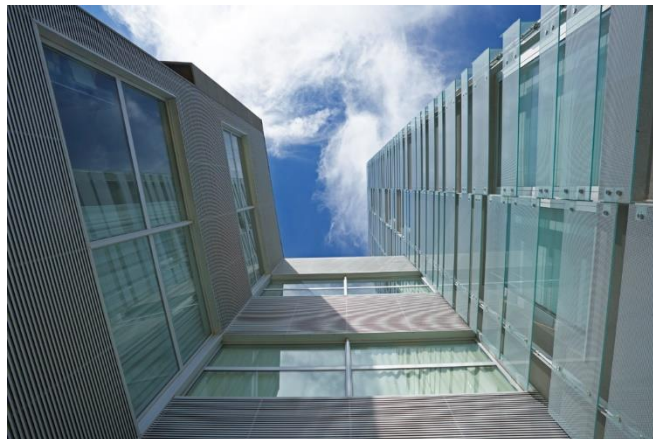
Figura 13- Edifício com caixilharia Extrusal, especificamente com o tratamento AC20NA (Fonte: Extrusal S.A.)
