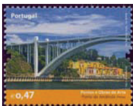
Fig. 171 - Emissão “Pontes e Obras de Arte - Ponte da arrábida”. Túlio Coelho e Atelier Acácio Santos. 2008.
