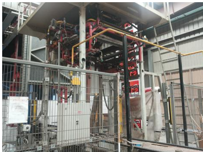
Figura 3.17 - Empacotamento do produto cozido
