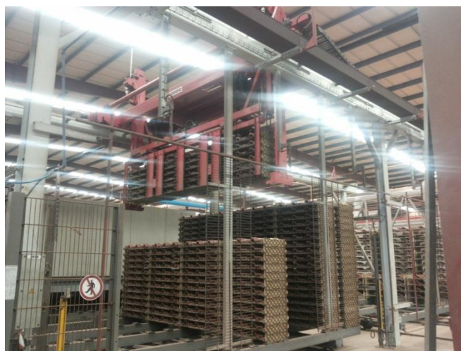
Figura 3.12 - Descarga de vagonetas
