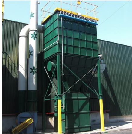
Figura 12 – Imagem ilustrativa de um filtro de mangas (Fonte: URL 3).
