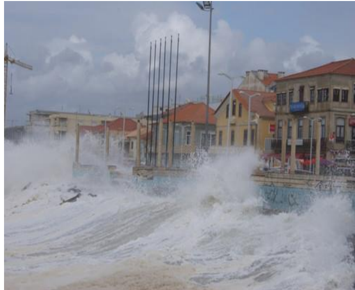
Figura 52 – Forte agitação marítima, marcada por episódios de galgamentos costeiros sobre a malha urbana da praia do Furadouro (Fonte: Notícias de Aveiro, Novembro de 2010).
