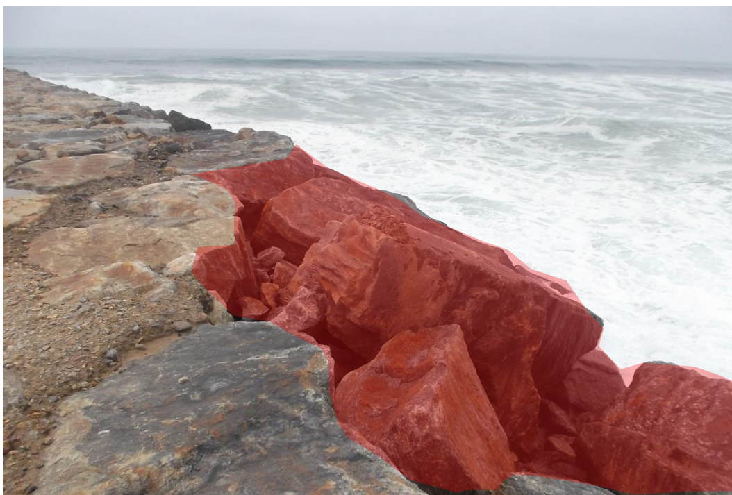
Figura 41 – Representação do rombo encontrado aproximadamente a 60 m da cabeça do esporão E4, na praia de Cortegaça (Fonte: DA-CMO, 4 de Junho de 2015).
