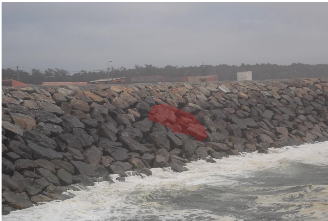
Figura 39 – Representação do abatimento pontual encontrado na DA4, na praia de Esmoriz (Fonte: DA-CMO, 4 de Junho de 2015).
