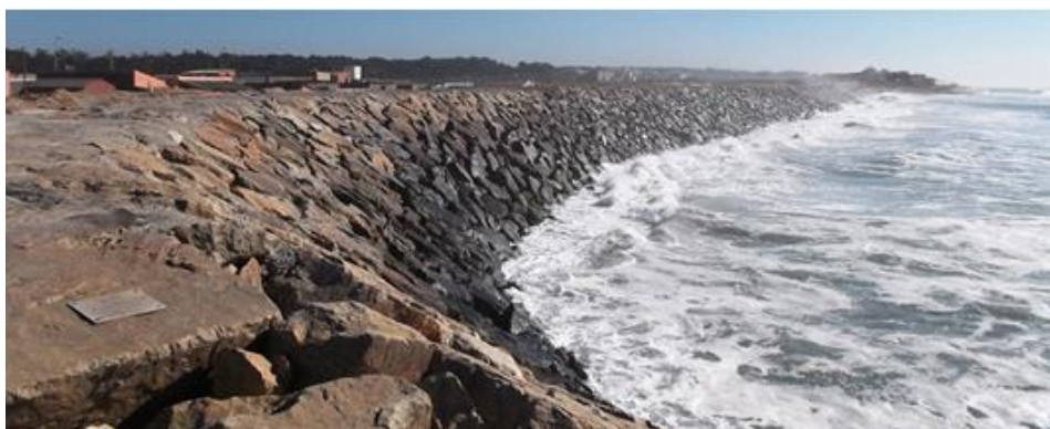
Figura 5 – Obra longitudinal aderente na praia de Esmoriz (Fonte: DA-CMO, 6 de Março de 2015).
