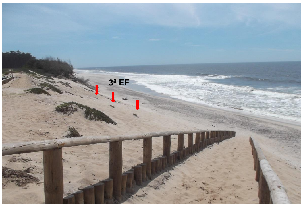
Figura 42 – Representação da 3ª fase da obra longitudinal por estacaria frontal, na praia de Maceda (Fonte: DA-CMO, 8 de Junho de 2015).
