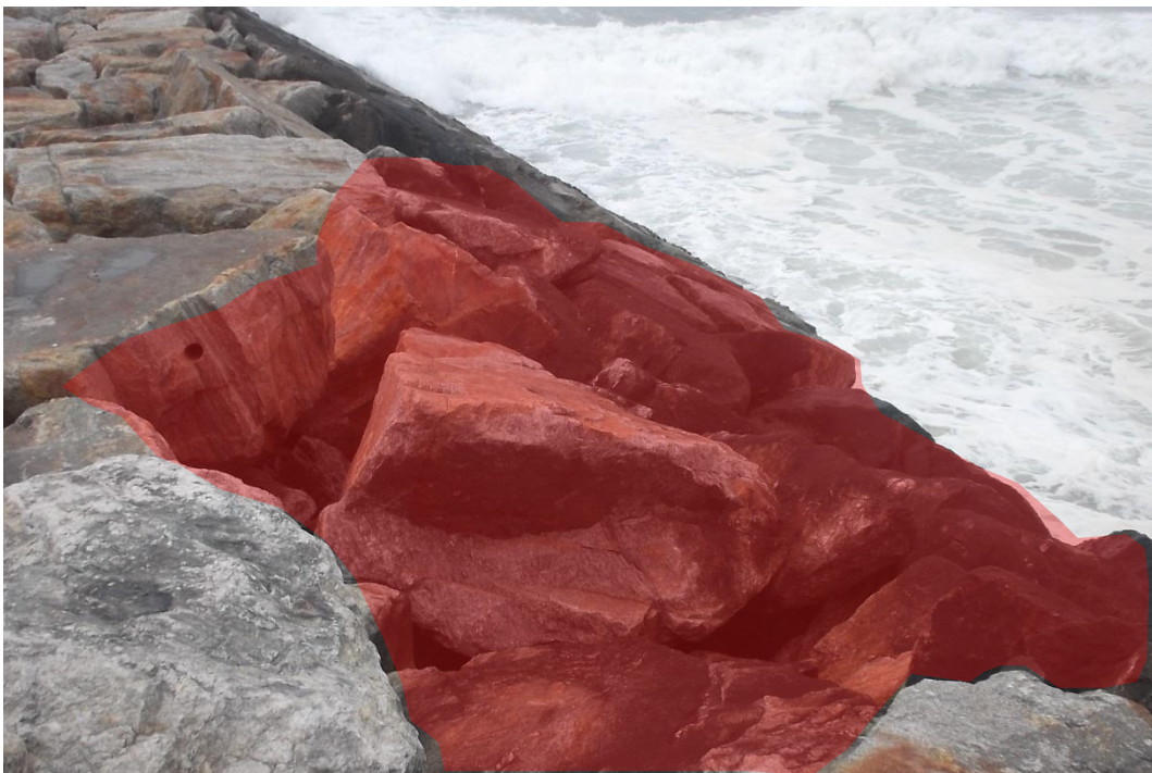
Figura 38 – Representação da cratera encontrada aproximadamente a 80 m da cabeça do esporão E2, na praia de Esmoriz (Fonte: DA-CMO, 4 de Junho de 2015).
