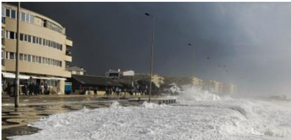
Figura 10 – Galgamento costeiro sobre a obra longitudinal aderente imediatamente a sotamar no esporão norte da praia do Furadouro, originando inundações na malha urbana adjacente (Fonte: Ovarnews, 2014).
