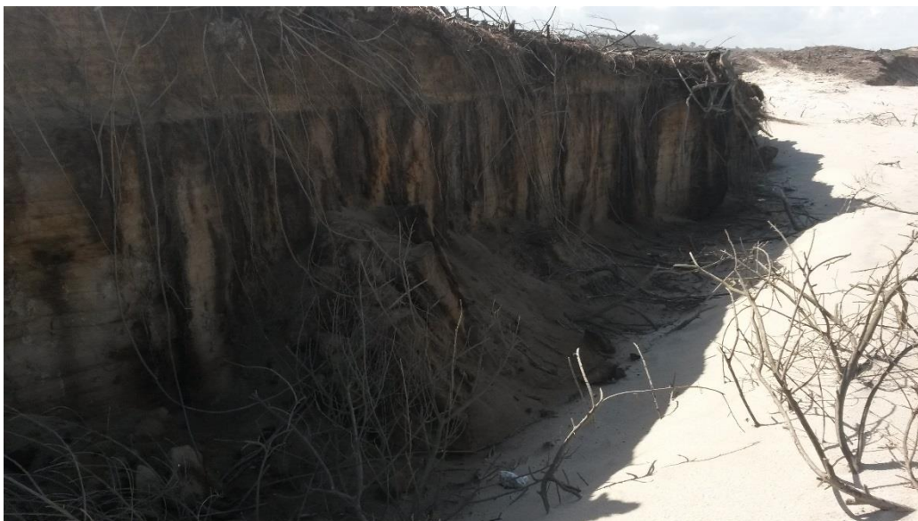
Figura 25 – Zona da praia de Cortegaça, onde é evidente a destruição total de parte do cordão dunar frontal (Fonte: DA-CMO, 27 de Abril de 2015)
