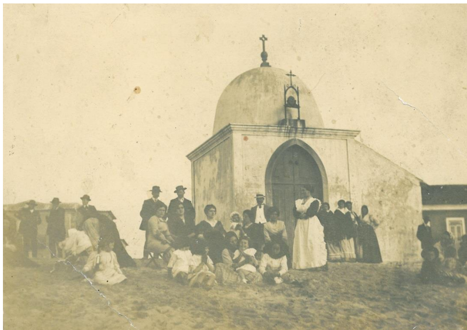
Figura 47 – Capela Velha do Senhor da Piedade implantada na praia do Furadouro (Fonte: Anónimo, retirado de DA-CMO, 2015).
