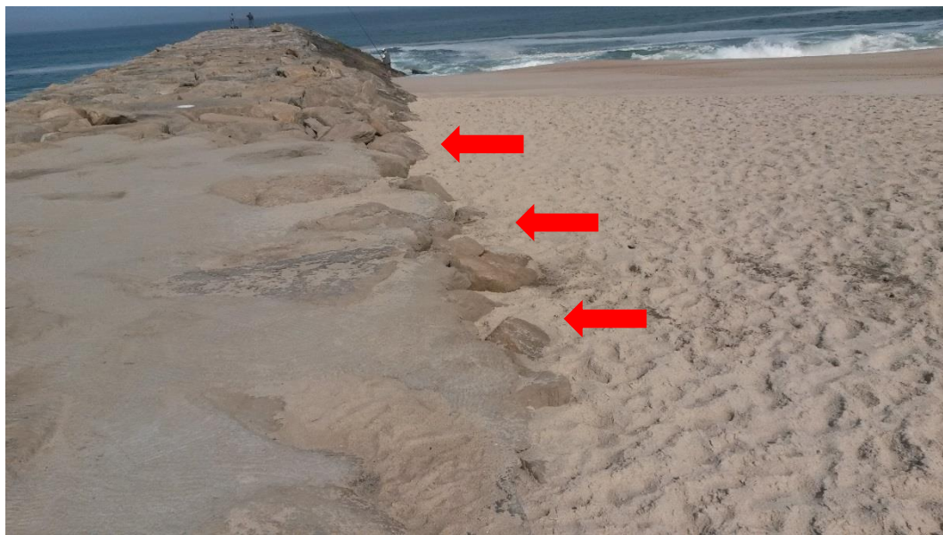
Figura 45 – Representação da colmatação de sedimentos existente no talude a barlamar do esporão E6, na praia do Furadouro (Fonte: DA-CMO, 8 de Junho de 2015).
