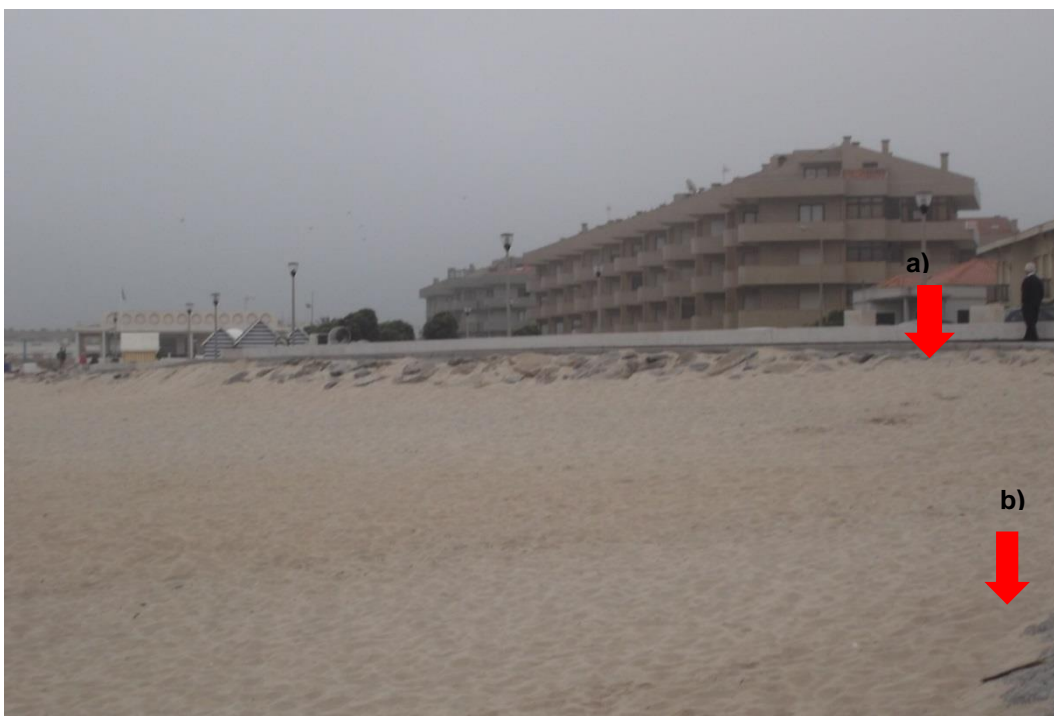
Figura 37 – Obra longitudinal aderente DA1 em simultâneo com o esporão E1, evidenciando boa colmatção de sedimentos, na praia de Esmoriz (Fonte: DA-CMO, 4 de Junho de 2015).
