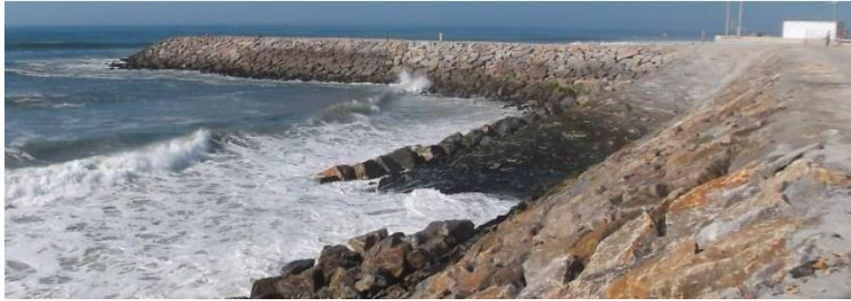
Figura 6 – Esporão em simultâneo com uma obra longitudinal aderente, na praia do Furadouro (Fonte: DA-CMO, 6 de Março de 2015)
