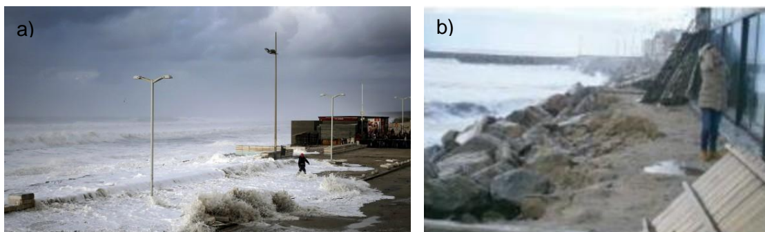
Figura 53 – Consequências das intempéries na praia do Furadouro. a) Galgamento costeiro da obra longitudinal aderente no troço norte da praia (Fonte: Ovarnews, 2014); b) Destruição de um estabelecimento comercial localizado na zona sul da praia (Fonte: Relatório Nacional de Ocorrências, 2014).
