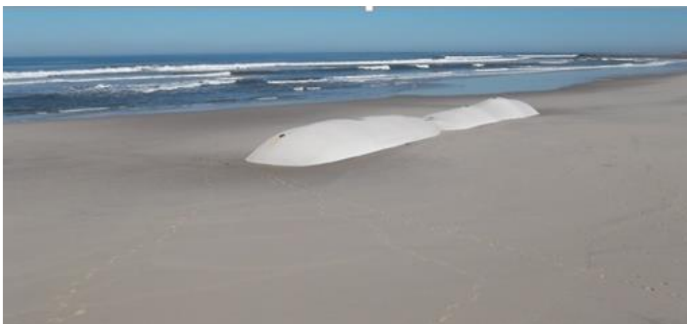
Figura 21 – Geotubo implantado a barlar do esporão sul da praia de Cortegaça (Fonte: DA-CMO, 6 de Março de 2015).
