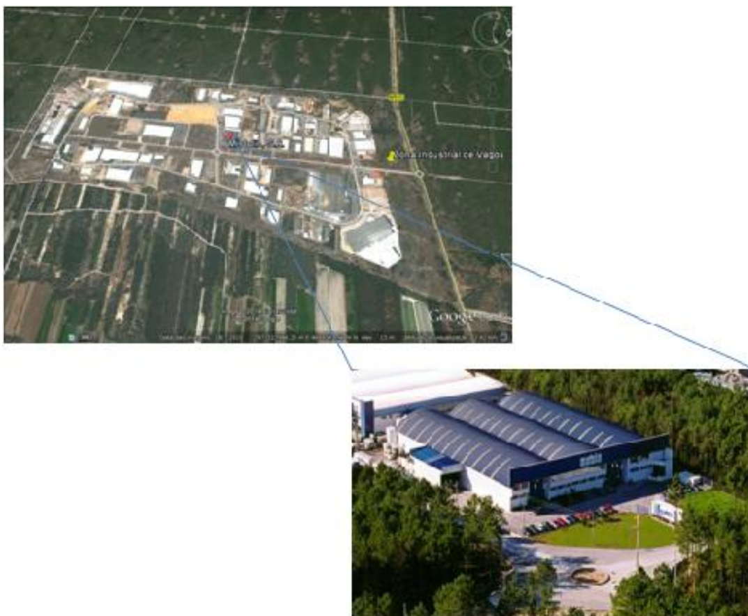
Figura 8: Instalações da Mistolin S.A., Zona industrial de Vagos.
