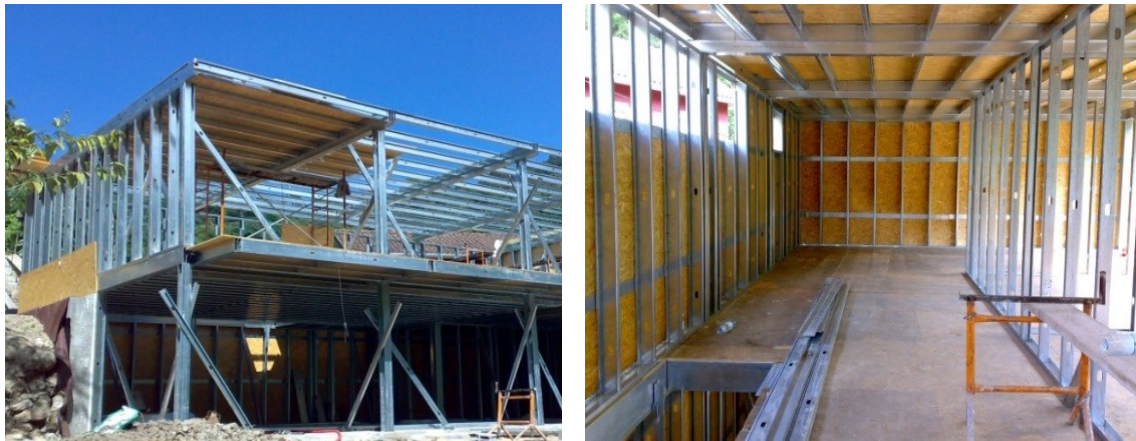
Figura 81 – Lajes secas (Obras da PRORUAN - Cinfães).
