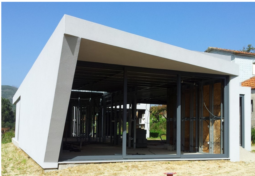
Figura 93– Obra da PRORUAN realizada em Vale de Cambra (Ano 2014).
