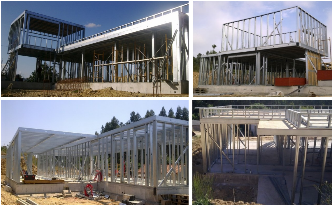
Figura 79– Estrutura em LSF (Obras da PRORUAN - Albergaria-a-Velha).
