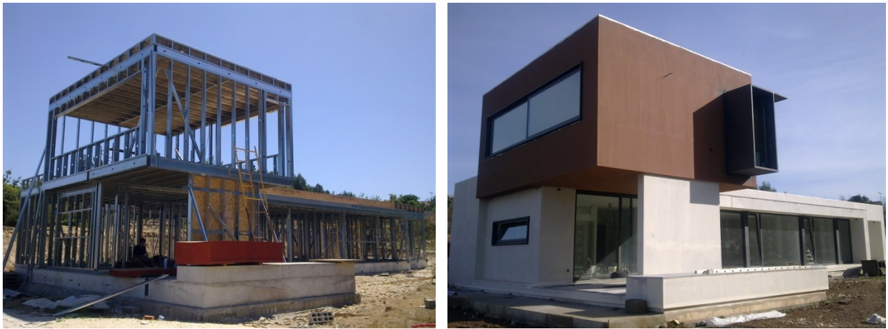
Figura 89– Obra da PRORUAN realizada em Albergaria-a-Nova (Ano 2009).
