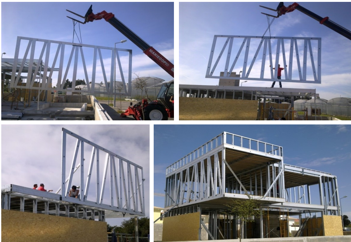
Figura 1– Montagem da estrutura (Obra da PRORUAN - Ílhavo).
