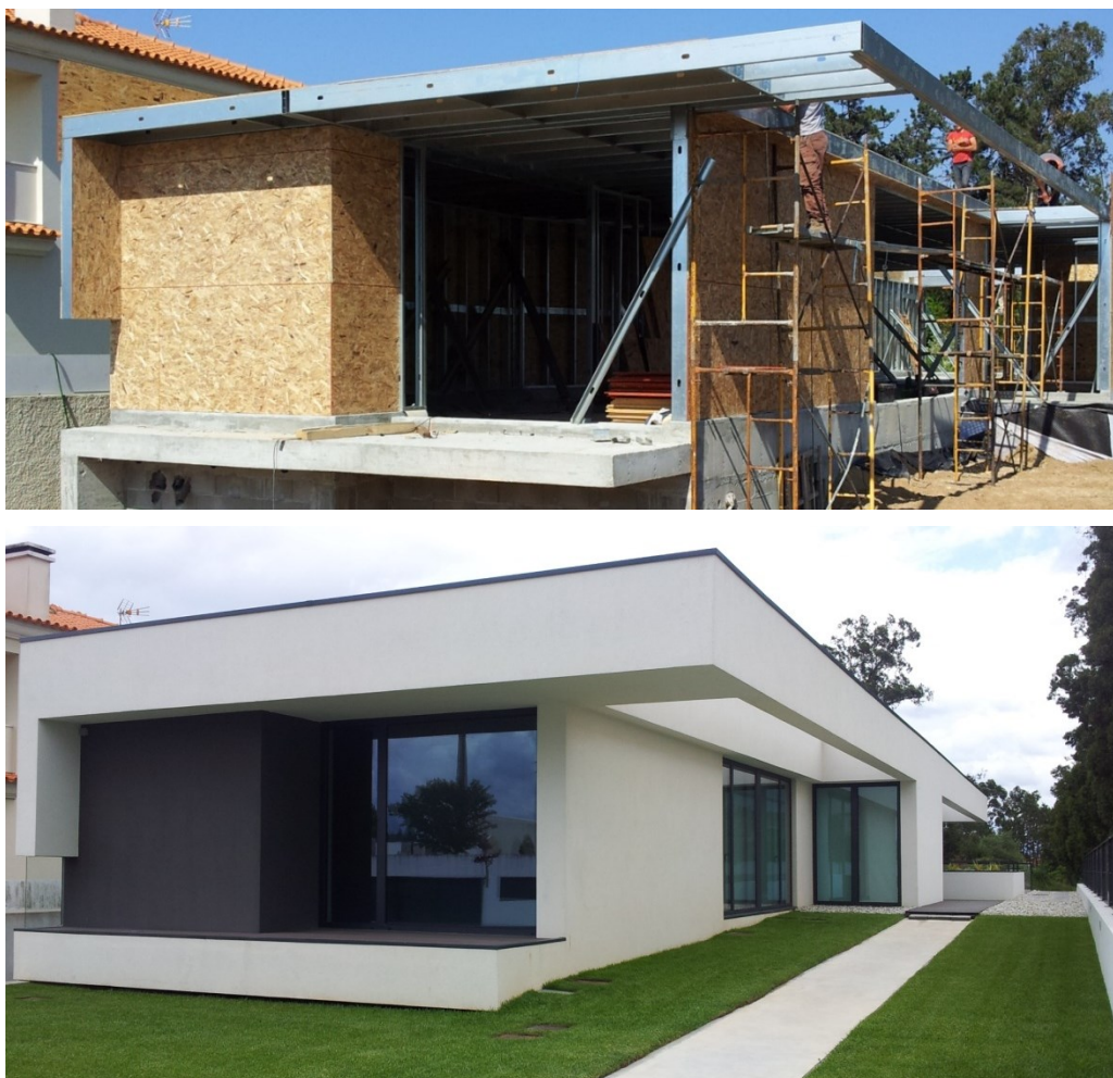
Figura 92– Obra da PRORUAN realizada em S. Bernardo (Ano 2012).
