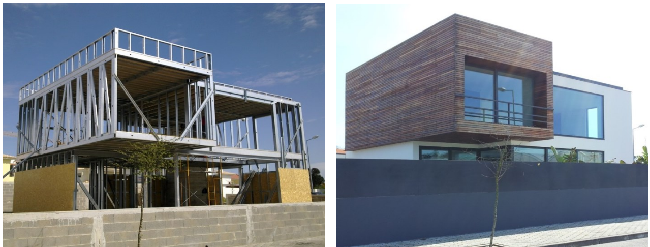
Figura 90– Obra da PRORUAN realizada em Ílhavo (Ano 2010).
