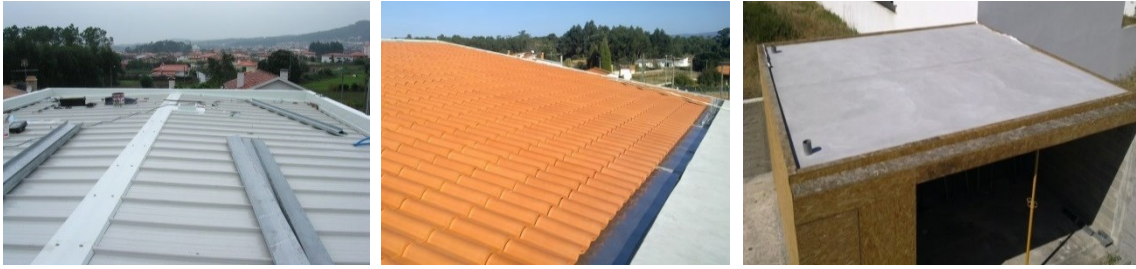
Figura 82– Lajes húmidas (Obras da PRORUAN - Branca, Águeda e Ílhavo).
