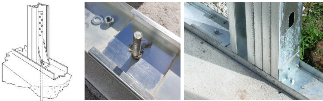
Figura 86– Pormenor de ancoragem ( Obra da PRORUAN – Albergaria-a-Velha).
