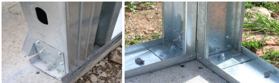
Figura 78– Fixação da estrutura a fundação (Obra da PRORUAN - Albergaria-a-Velha).
