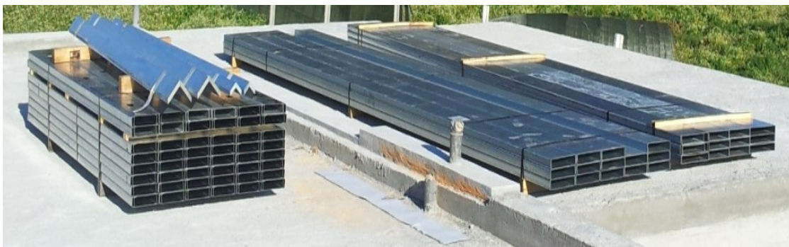
Figura 3– Perfis em aço galvanizado descarregado na obra de S.Bernado.
