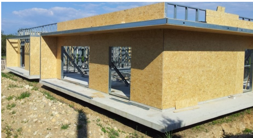
Figura 4– Revestimento da estrutura com placas OSB (Obra da PRORUAN – Alquerubim).
