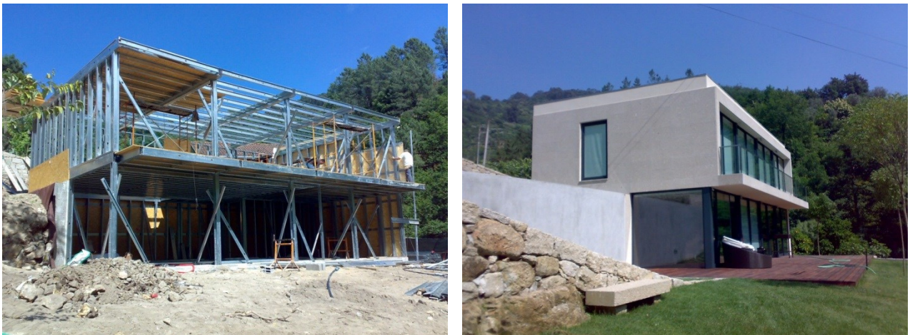
Figura 88– Obra da PRORUAN realizada em Cinfães (Ano 2008).
