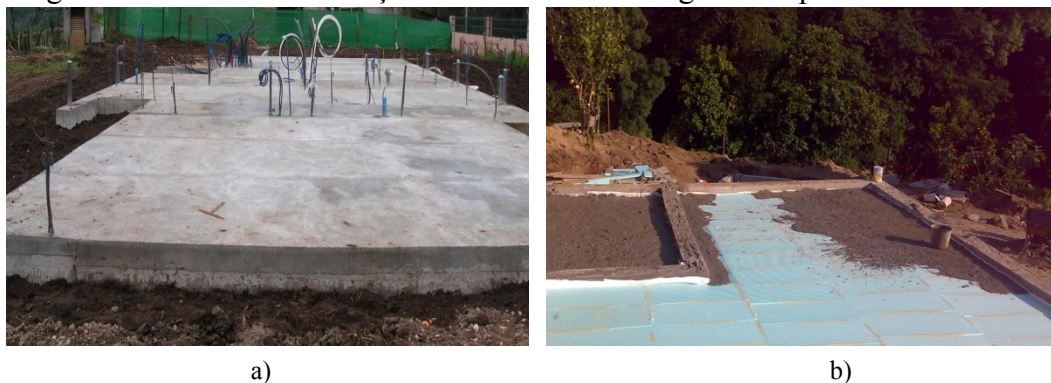
Figura 77– Fundações (Obras da PRORUAN - Branca e Cinfães)
