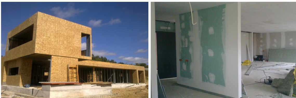
Figura 80– Placas OSB e de gesso acartonado (Obra da PRORUAN - Albergaria-a-Velha).
