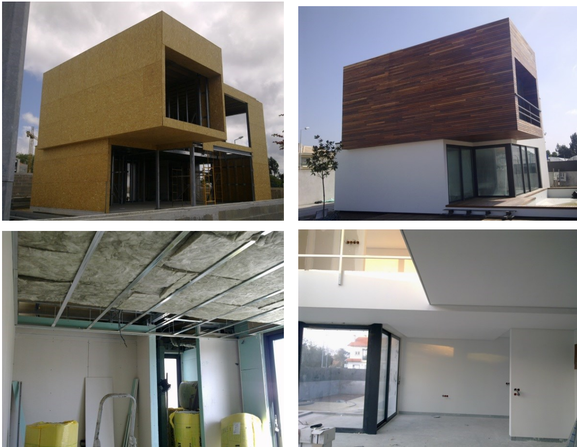
Figura 2– Revestimentos exteriores e interiores (Obra da PRORUAN - Ílhavo).
