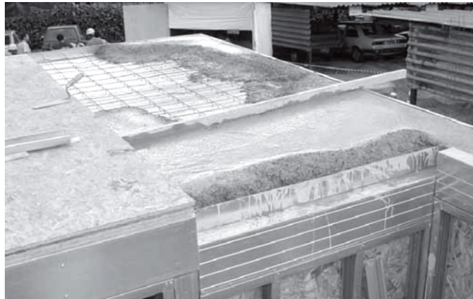
Figura 40– Cobertura plana (Freitas et al., 2006)
