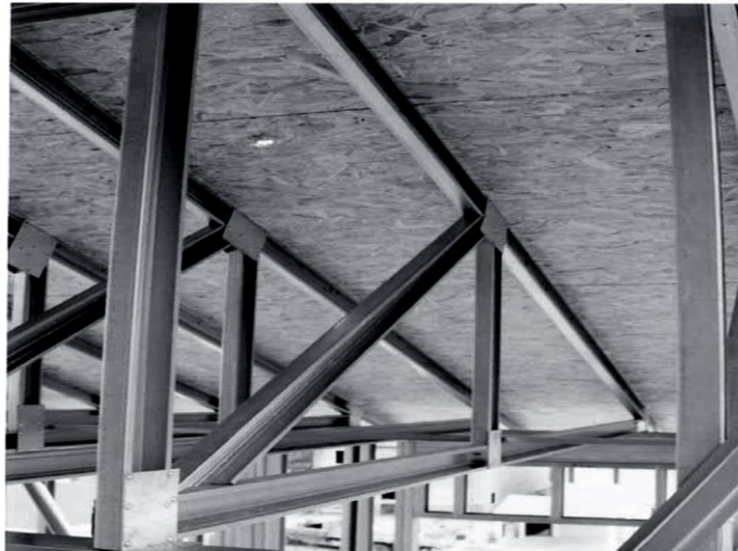
Figura 42– Cobertura inclinada com treliças (Freitas et al., 2006).
