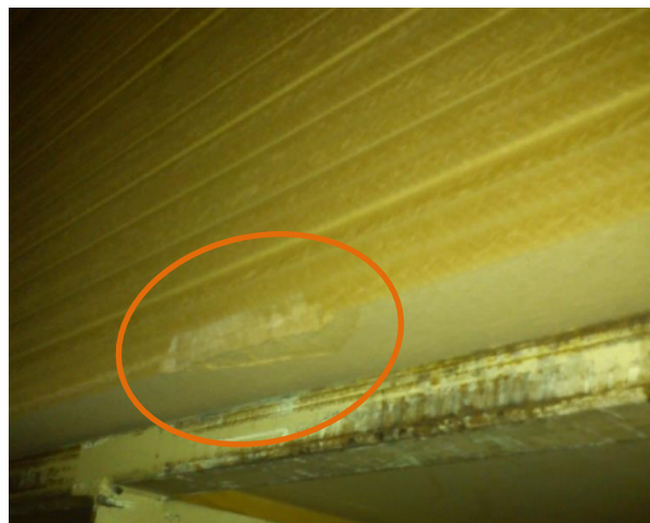
Figura 35 - Exemplo de placa lascada das garras do Luki .
