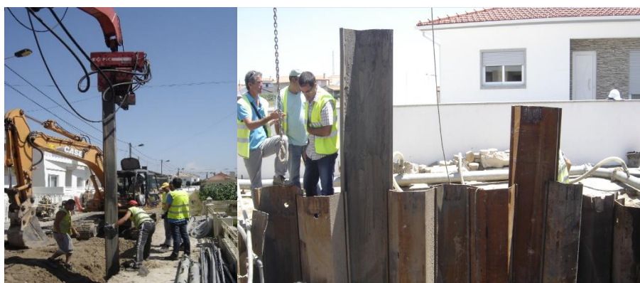
Figura 13 – Cravação de estacas-prancha de ferro na proximidade de habitações
