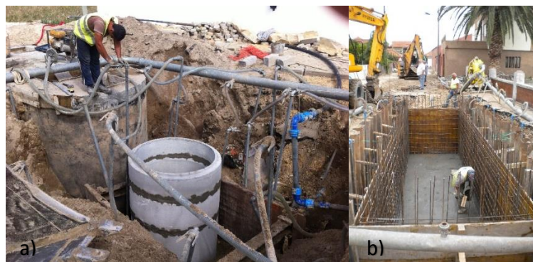
Figura 18 – a) Utilização de argamassa na fixação dos anéis de betão pré-fabricados que executam as caixas de visita b) Utilização de betão na execução das estações elevatórias
