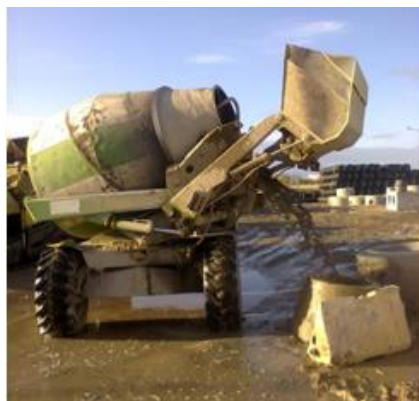
Figura 17 – Descarga das águas de lavagem da caleira da autobetoneira no solo
