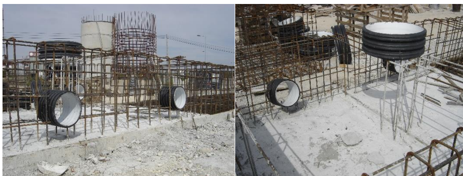
Figura 25 – Utilização de pontas de coletores na execução de cofragens
