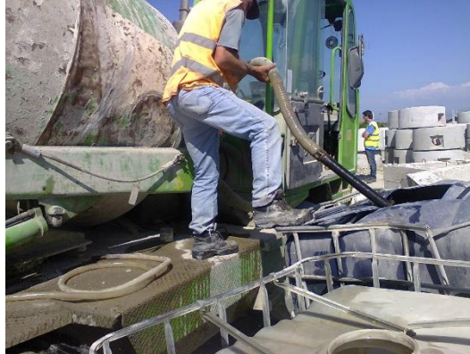
Figura 15 – Abastecimento da caleira da autobetoneira com água armazenada no contentor para granel e proveniente do rebaixamento do nível freático
