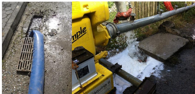
Figura 16 – Drenagem da água subterrânea proveniente do rebaixamento do nível freático
