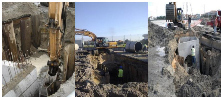
Figura 19 – Execução dos trabalhos no Terminar Norte do Porto de Aveiro
