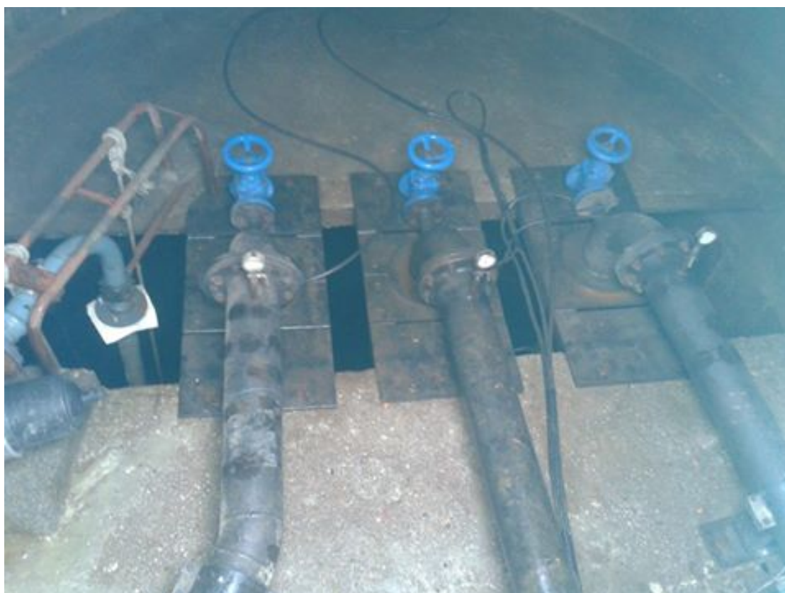
Figura 16 – Motores para extração de água do rio na estação de tratamento de águas
