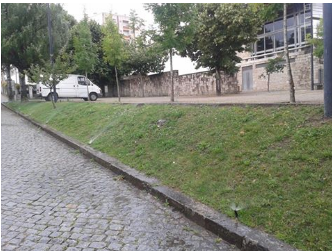
Figura 10 – Aspeto dos aspersores de rega automática junto à marginal do rio Lima
