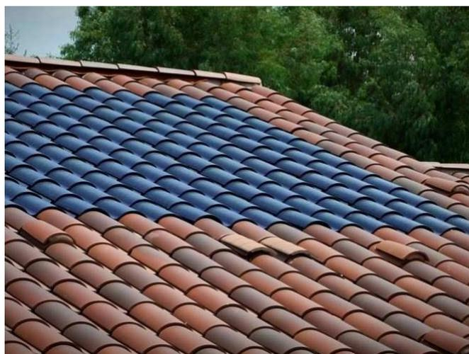
Figura 2.5: Integração em cobertura por intermédio de telhas fotovoltaicas [28]
