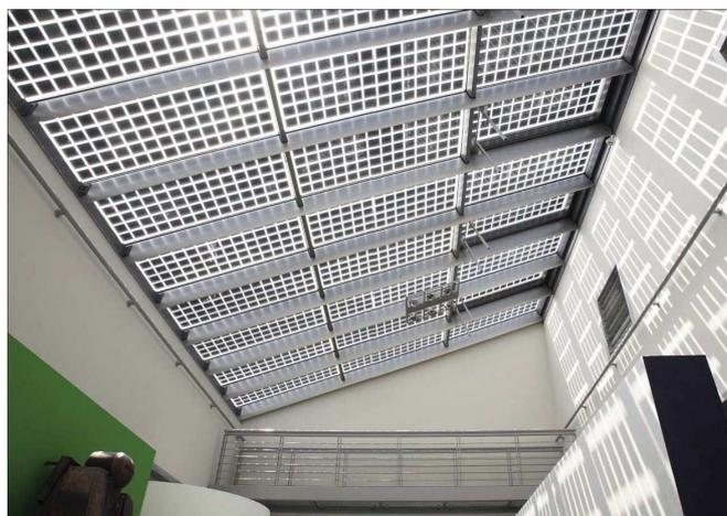
Figura 2.4: Integração do fotovoltaico em cobertura exemplificada num edifício com módulos Sapa Solar [42]
