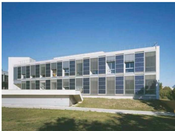
Figura 2.6: Integração fotovoltaica em fachada vertical exemplificada no edifício Solar XXI do Laboratório Nacional de Energia e Geologia, no qual se verifica alguma penalização por sombreamento.[27]
