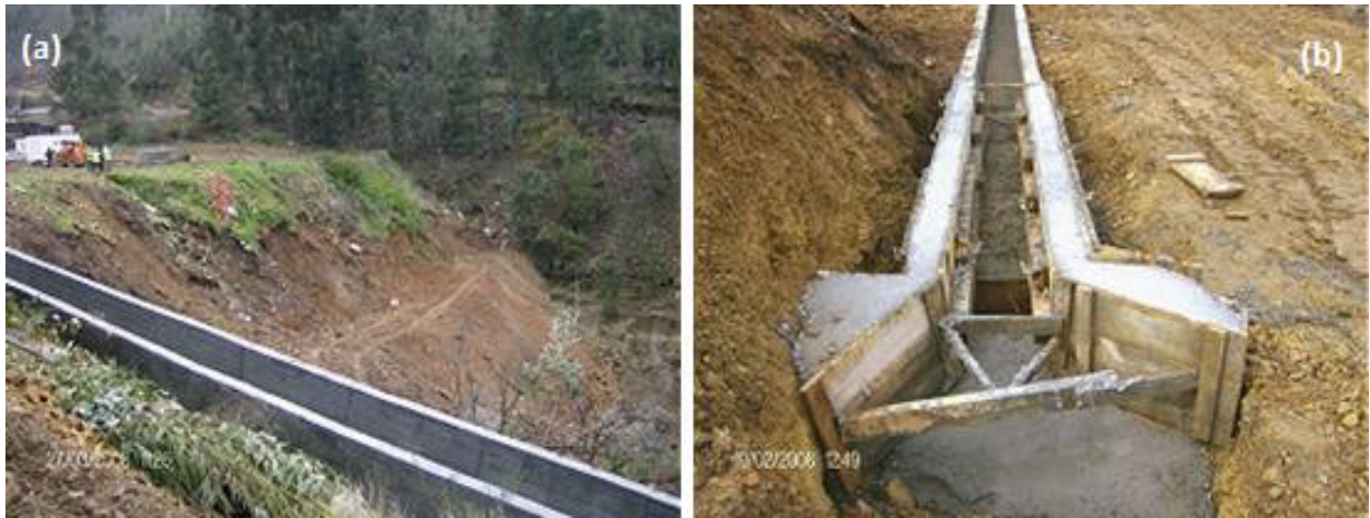
Figura 2.31 – (a) Vista do sistema de drenagem; (b) Execução das valetas perimetrais. Fotos de 2008 (fonte http://www.edm.pt/html/proj_terrामonte.htm ).
