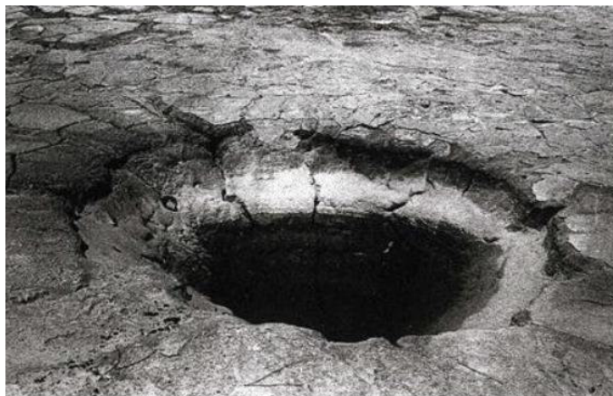
Figura 2.26 – Abatimento ocorrido sensivelmente a meio da escombreira (fonte: Nascimento, 1975b).
