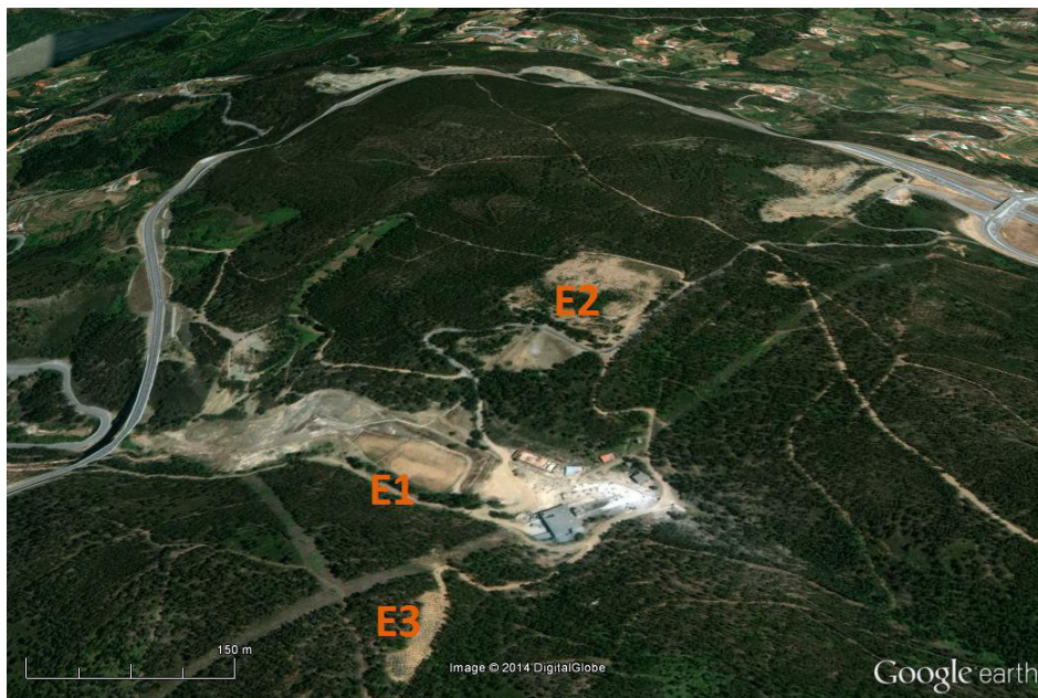
Figura 2.19 – Escombreyras da mina de Terramonte. Escombreyra E2 e E3 do tipo a “montante” e escombreyra E1 do tipo a “jusante”.
