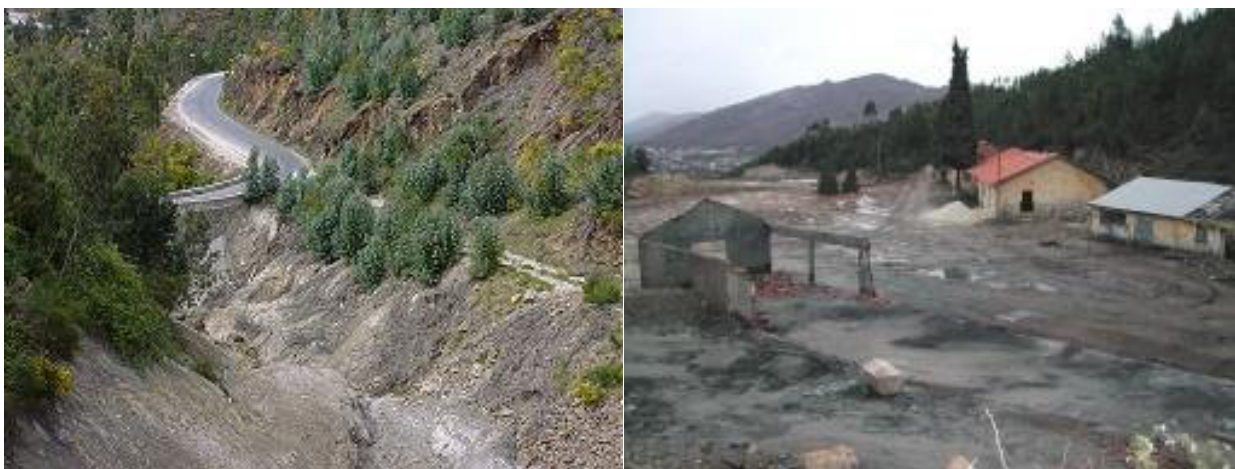
Figura 2.29 – Aspeto da área mineira de Terramonte antes da realização das obras de intervenção (a) Arraste de materiais finos da escombreira ao longo da linha de água; (b) Ruínas das antigas instalações da lavaria. Fotos de 2005 (fonte: http://www.edm.pt/html/proj_terrmonete.htm )
