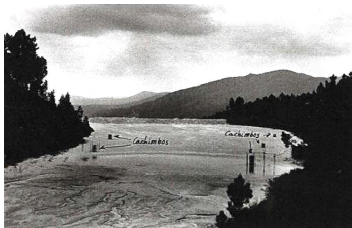
Figura 2.25 – Área de deposição dos finos, onde é visível água acumulada, por falta de escoamento dos cachimbos (fonte: Nascimento, 1975a).
