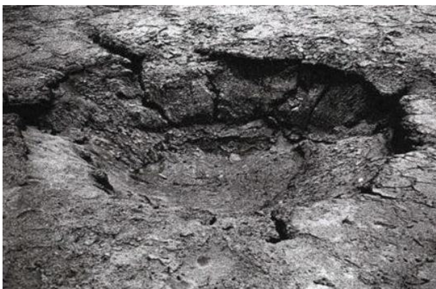
Figura 2.27 – Abatimento da escombreira (fonte: Nascimento, 1975c).
