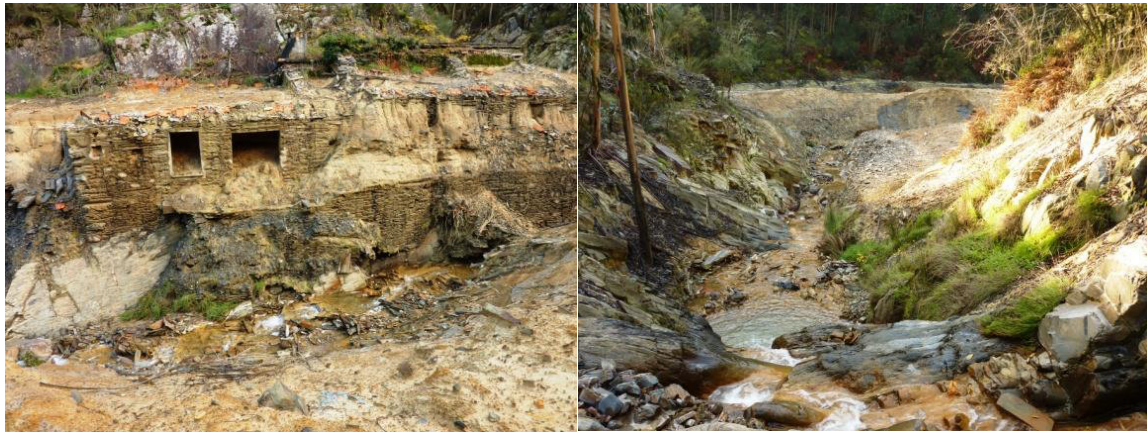
Figura 4.9 – Aspeto da acumulação de materiais finos ao longo da ribeira da Castanheira.
