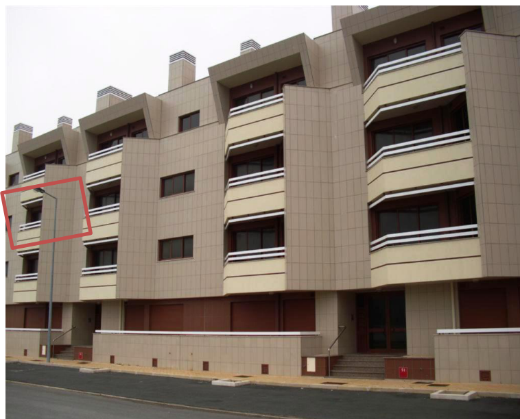
Figura 67 – Apartamento T2 construção recente (caso de estudo 3)
