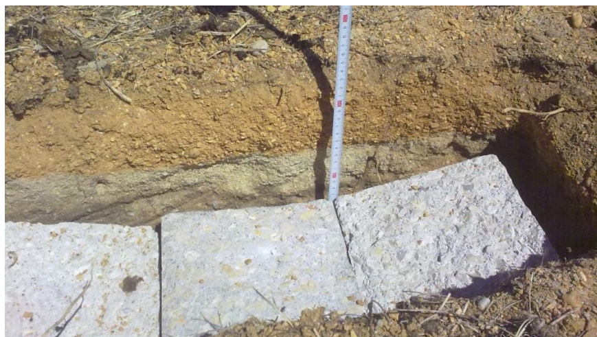
Figura 4.14 - Blocos de betão utilizados para criar uma estrutura resistiva.
