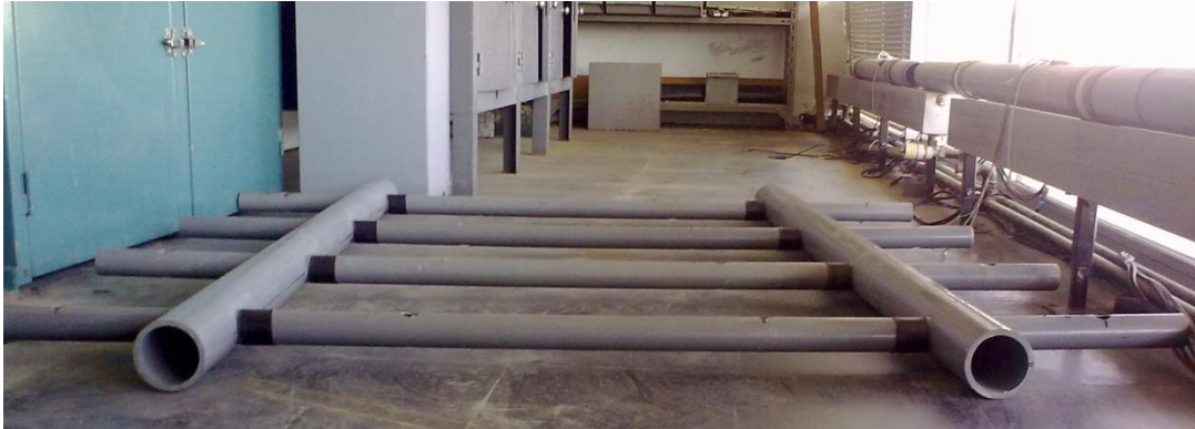
Figura 3.9 - Reforço da estrutura de suporte com tubos de PVC de menor dimensão.
