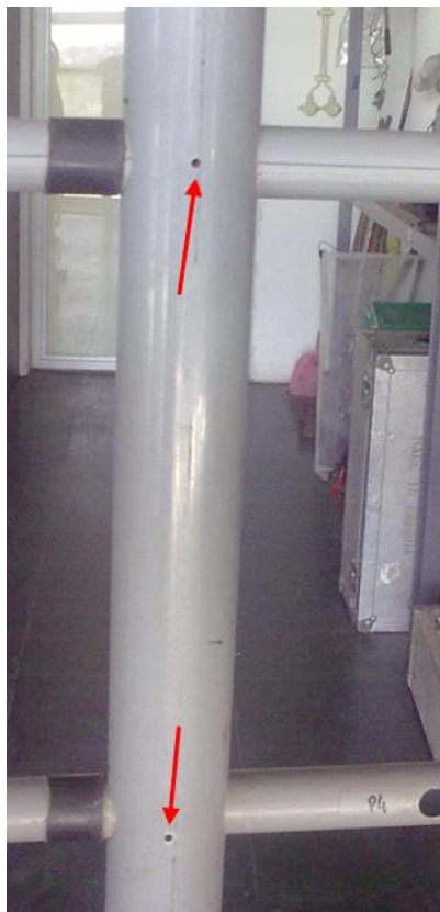
Figura 3.10 - Cavilhas colocadas na estrutura para evitar erros de geometria.
