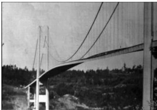
Figura 1.3 - Colapso da ponte de Tacoma Narrows [7].
