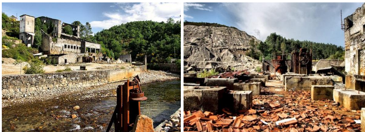
Figura 3.4. Exemplos de resíduos de construção e demolição observados nas antigas instalações da mina da Borralha – Lavaría Velha.
