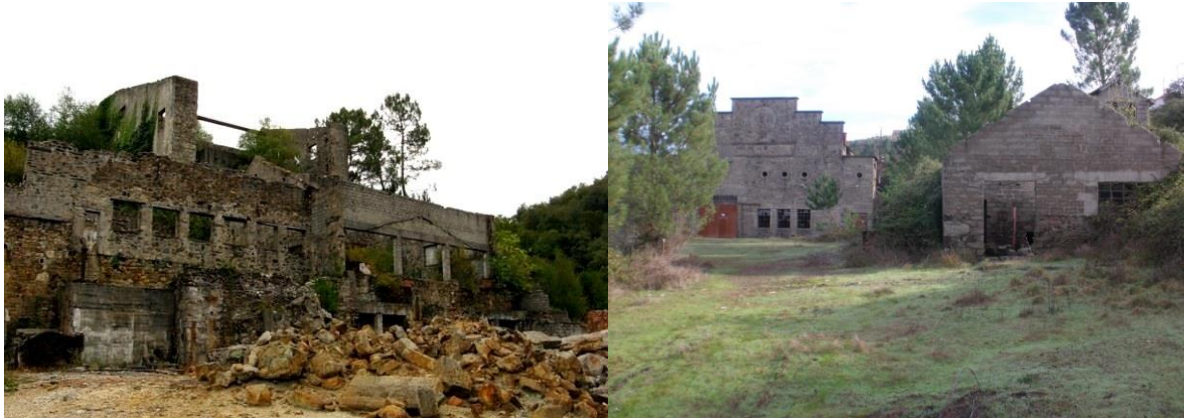
Figura 3.6. Imagens das infraestruturas da mina da Borralha: (a) lavaría velha; (b) fundição e casa do moinho (imagens cedidas pelo Ecomuseu do Barroso e Sousa, 2010).
