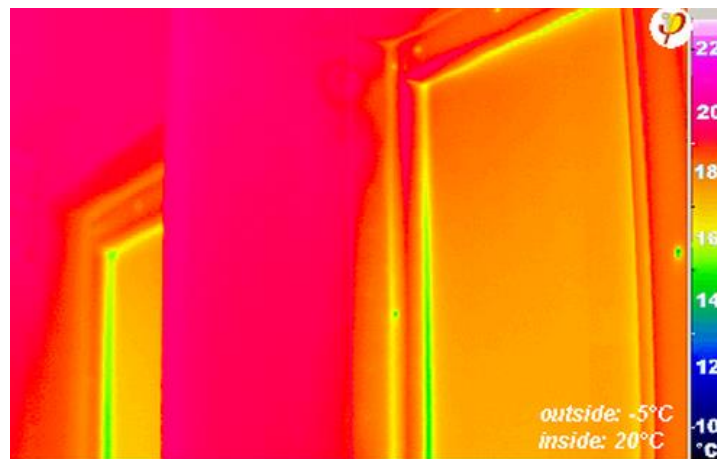
Figura 5 - Imagem de infravermelhos do interior de uma janela de uma Passive House – retirado de [8]
