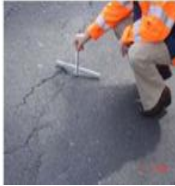
Figura 5 - Deformação localizada (Alves, 2007)
