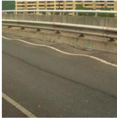
Figura 3 - Ondulação (Alves, 2007)
