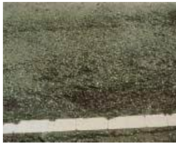
Figura 11 - Desagregação superficial (Miller & Bellinger, 2003)
