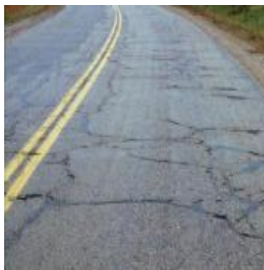
Figura 6 - Fendas parabólicas (Maia, 2012)
