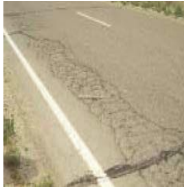
Figura 7 - Fendas de fadiga (Alves, 2007)
