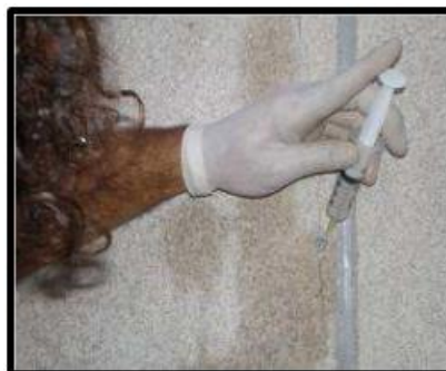
Figura 8 – Técnica de aplicação da calda de injeção (Tavares, 2009)
