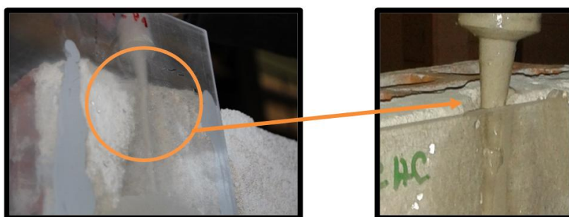
Figura 13 – Introdução da calda de injeção com uma seringa com as dimensões adequadas
