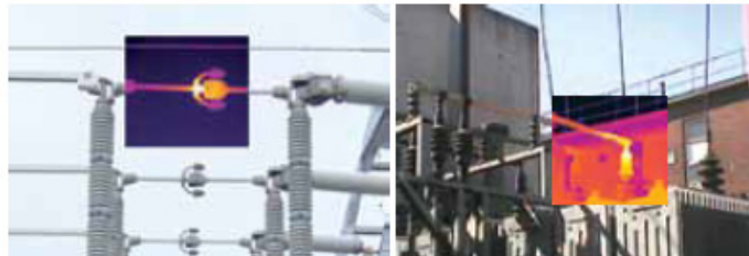
Figura 20 - Combinação de imagens que permite a pormenorização (FLIR Systems Inc., 2011).
