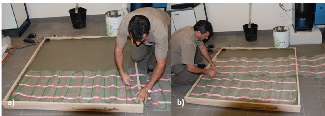
Figura 88 - Colocação da tela radiante: a) Corte da tela; b) Justaposição da tela.
