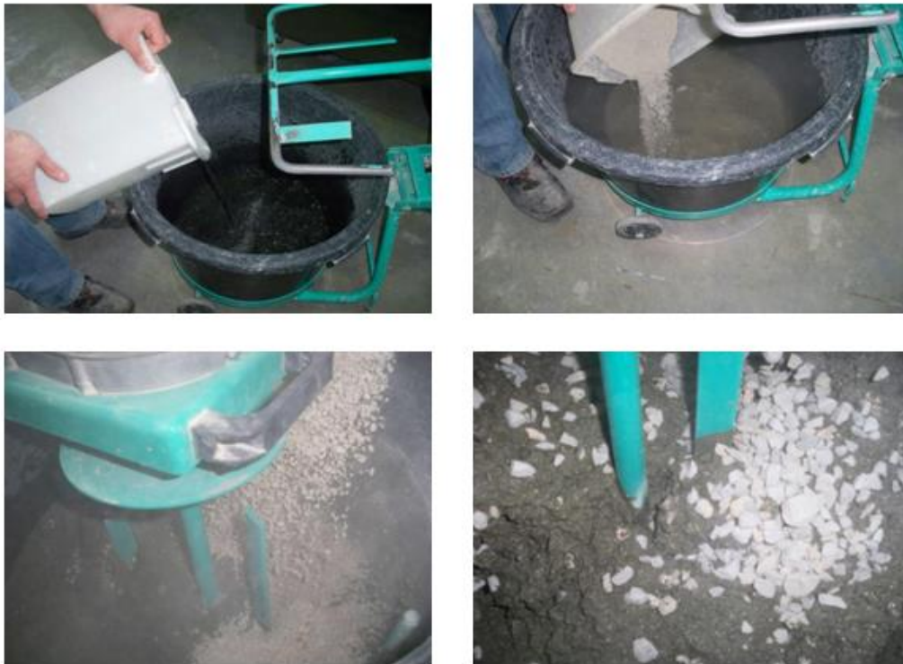
Figura 3.8- Fases do processo de mistura
