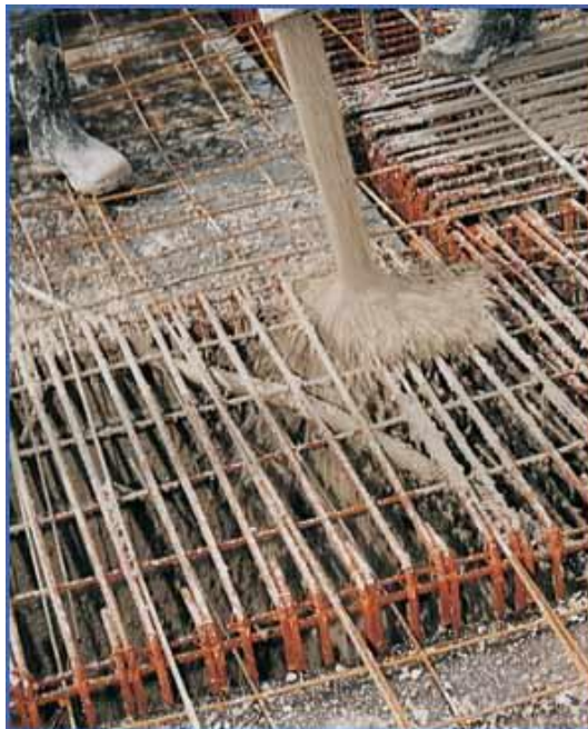
Figura 2.7- Zona densamente armada (retirado de www.abesc.org.br )
