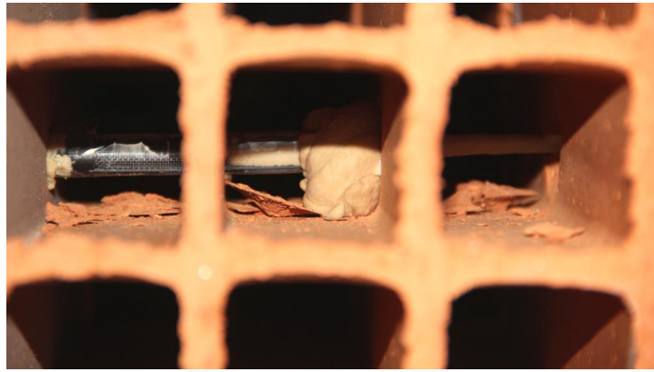
Figura 42: Manga insuficientemente cheia
