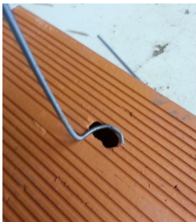
Figura 48: Dobra na extremidade do varão
