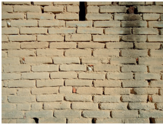
Fig. 36 - Estrutura de adobe de areia
