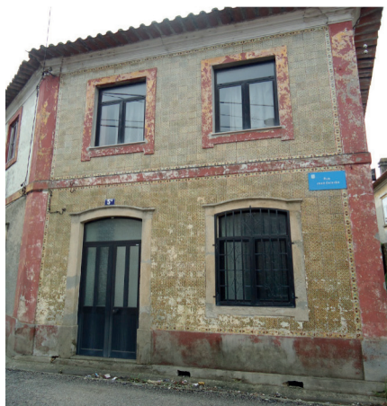
Fig.7 – Edifício com fachada revestida por azulejos aplicados em meados do século XIX. (Fachada completa, com degradação do vidrado, mas coloração mantida).
