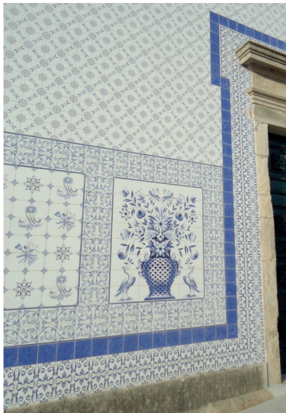
Detalhes das fachadas laterais
