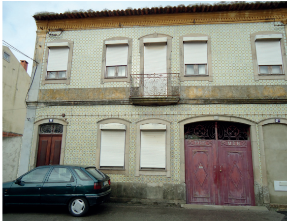
Fig.3 – Edifício com fachada totalmente revestida com azulejos aplicados no ano de 1906
