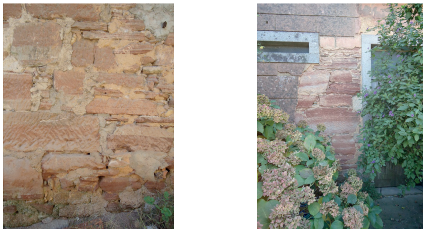
Fig. 38 – Fundações e alvenarias de rocha (pedra de Eirol)
