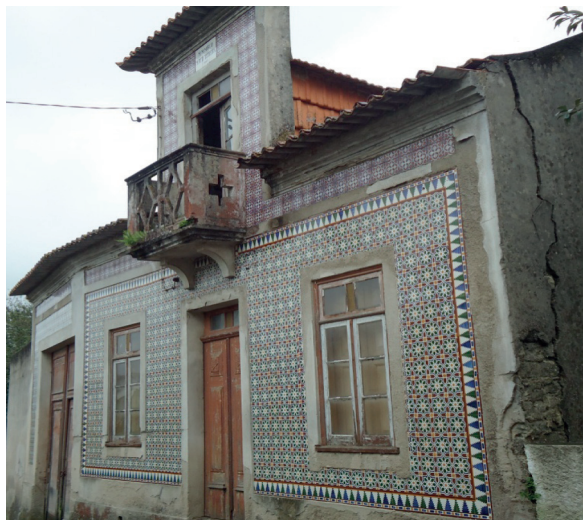
Fig.4 – Edifício com fachada totalmente revestida com azulejos colocados no ano de 1946
