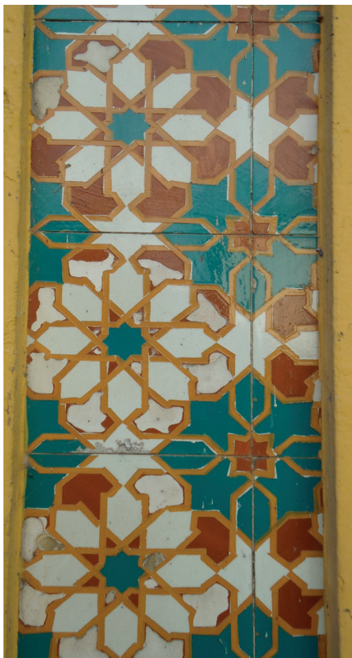
Edificação com o RCF com a anomalia da perda do vidro segundo a cor, pelos bordos, com algumas lacunas.
