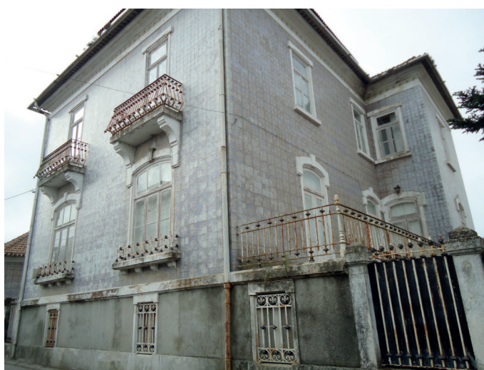
Fig.5 – Edifício totalmente revestido com azulejo aplicado na década de 70 do século XX
