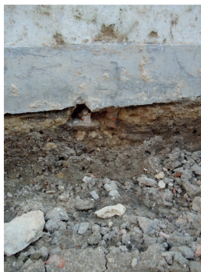
Fig.40 - Adobe assente diretamente na argila
