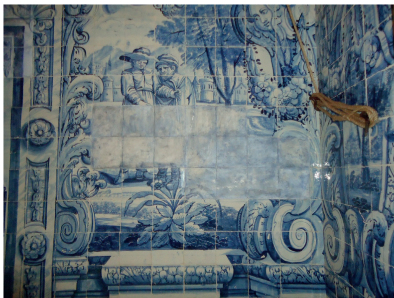
Fig. 30 – Restauro com aplicação de réplicas nos azulejos interiores da igreja das Carmelitas – Aveiro
