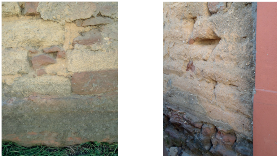
Fig. 37 – Fundações de rocha (pedra de Eirol) e alvenarias de adobe de areia amarela
