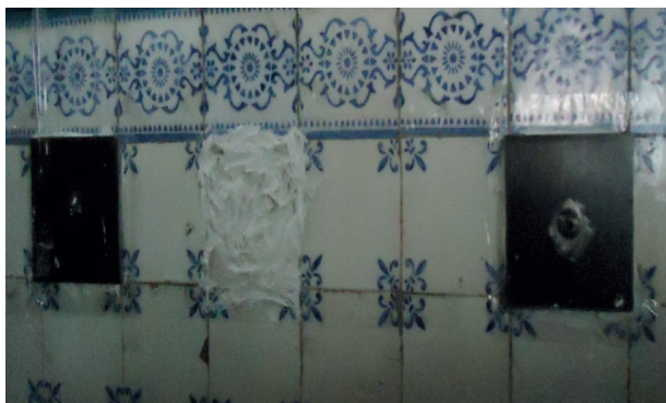
Fig. 55 - Colagem das pastilhas
