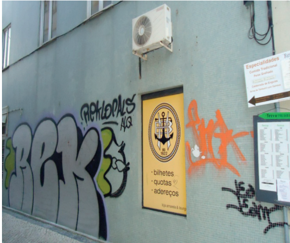
Edificação com RCF em pastilhas de 2x 2cm, cujas anomalias se devem a vandalismo (grafitis) e à ação humana em fixações de equipamentos.
