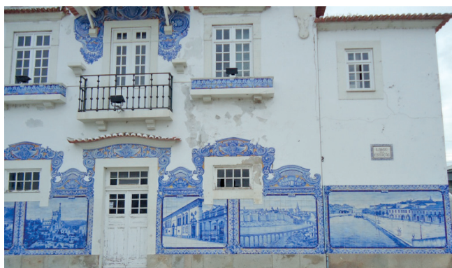
Fig. 2 – Edifício com painéis na fachada
