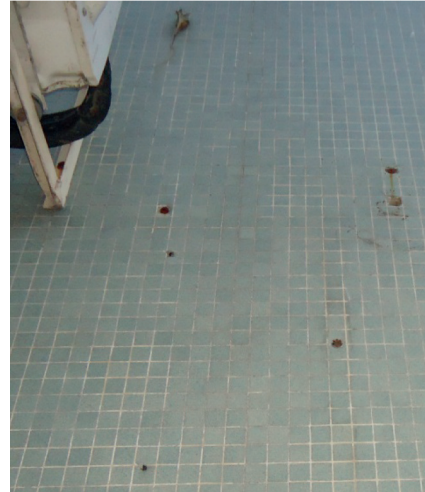
Edificação com RCF em pastilhas de 2x 2cm, cujas anomalias se devem a vandalismo (grafitis) e à ação humana em fixações de equipamentos.
