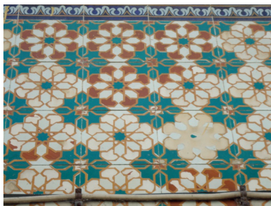
Edificação com o RCF com a anomalia da perda do vidro segundo a cor, pelos bordos, com algumas lacunas.
