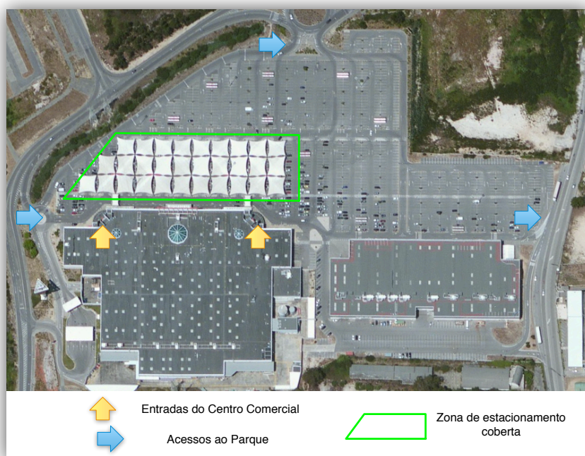
Figura 5.3: Centro comercial Aveiro Shopping Center e respetivo parque de estacionamento
