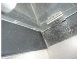
Figura 46 - Isolamento de porta com fita isoladora.
