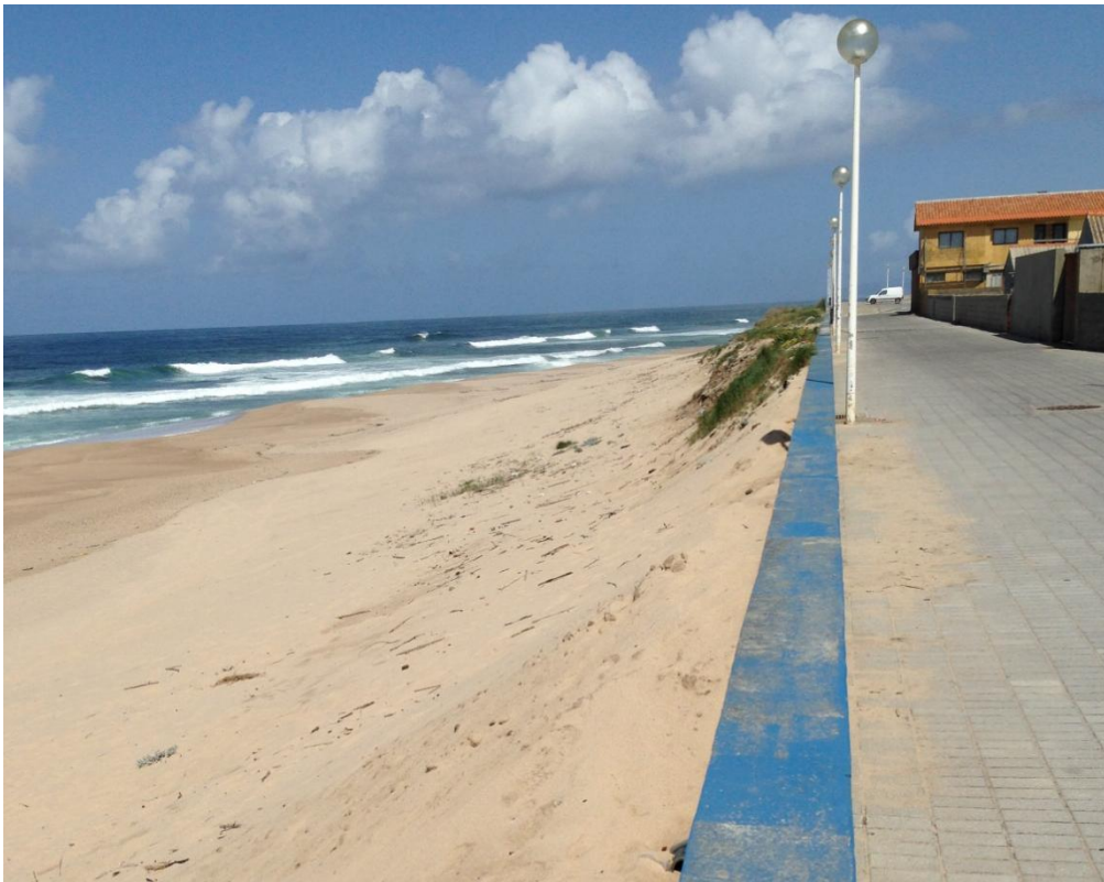
Figura 23 - Aspeto da marginal protegida por um muro de contenção no limite da alta praia, Aguçadoura (Abril, 2014).
