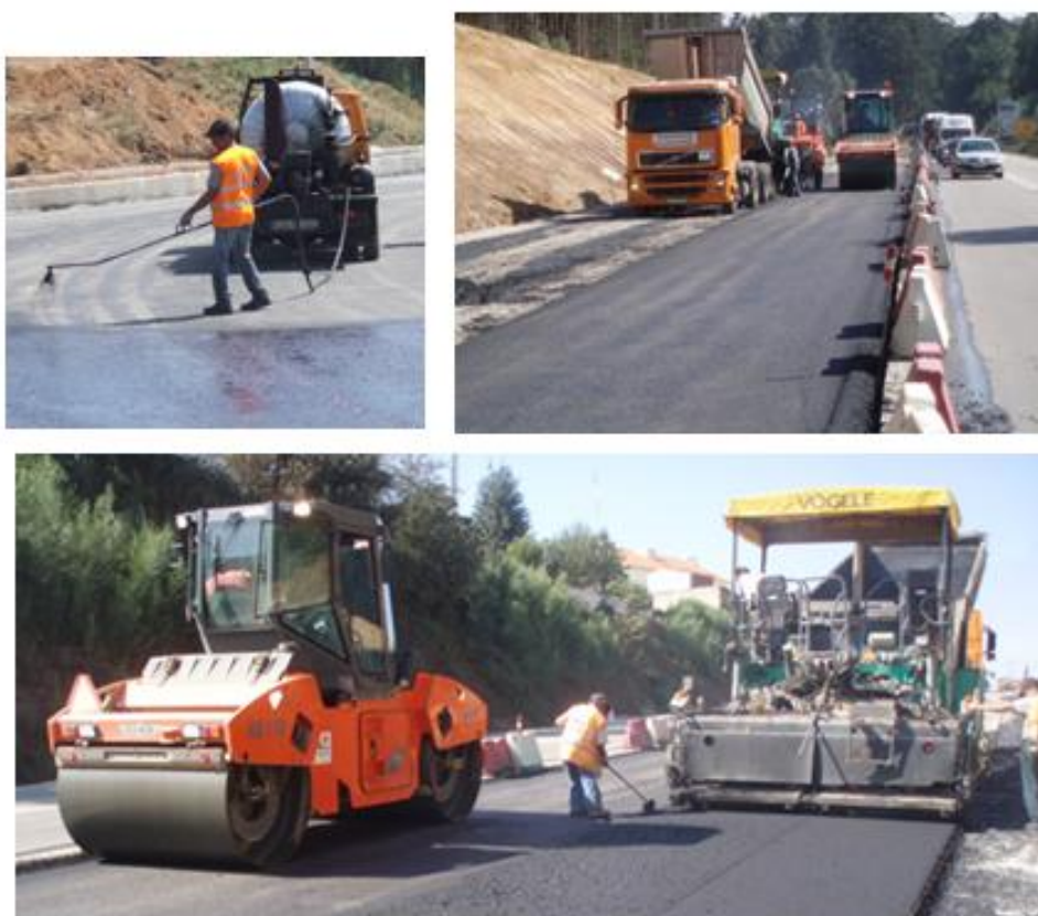
Figura 5.26 - Aplicação da mistura em obra (foto da autora)
