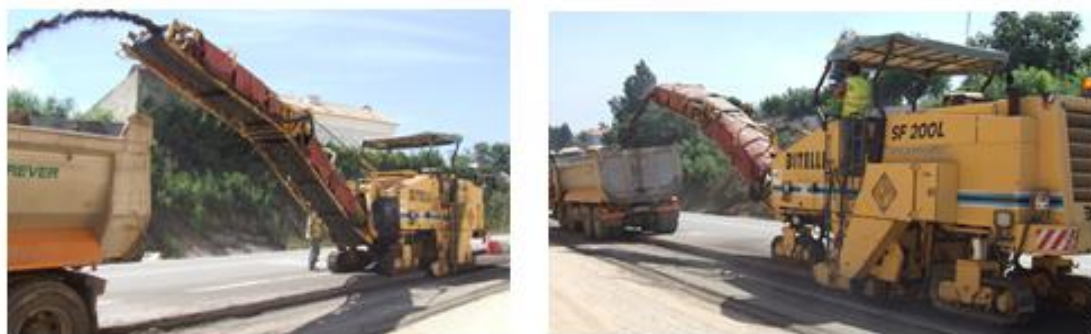
Figura 5.2 - Equipamento de fresagem do pavimento da EN1 em Albergaria (foto da autora)
