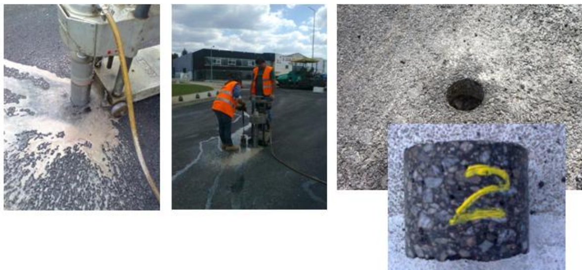
Figura 5.25 - Recolha de carotes na camada de pavimento (foto da autora)
