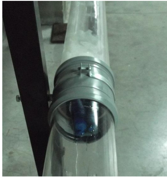
Figura 37. Deficiente união do ramal entre dois troços retilíneos deficiente ramal, entre dois troços retilíneos
