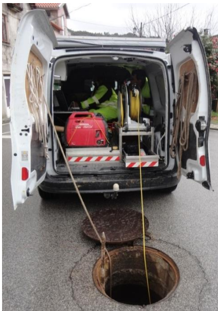
Figura 18 – Carrinha de inspeção CCTV.
